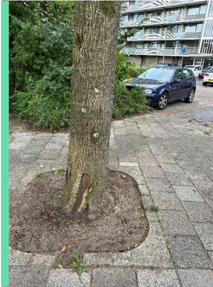
Foto 1 : schade stamvoet boomnr. 1
