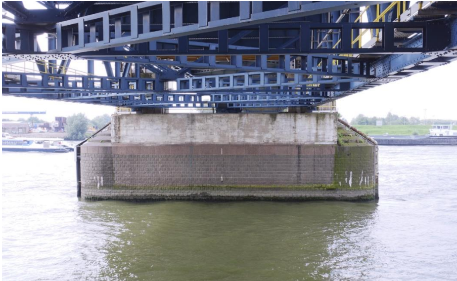
De oostelijke pijler, gezien vanaf de oostelijke oever.
