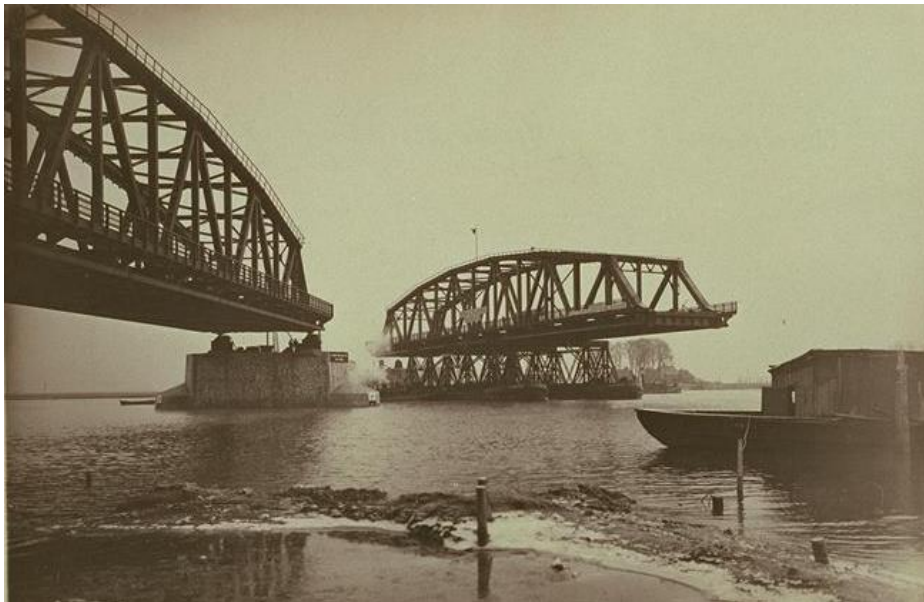
Het invaren van een brugdeel bij de bouw in 1931 van de brug over het Keizersveer in Noord Brabant. TIB nr. 708104.
