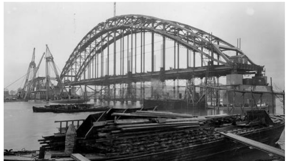
Zicht op het middendeel van de brug vanaf de oostelijke oever in oktober 1938. Aan de andere zijde wordt de aanbrug gerealiseerd. RWS Beeldbank.
