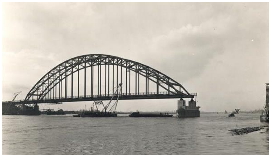
Zicht op de hoofdo overspanning van de brug over de Noord in maart 1939. RWS Beeldbank.
