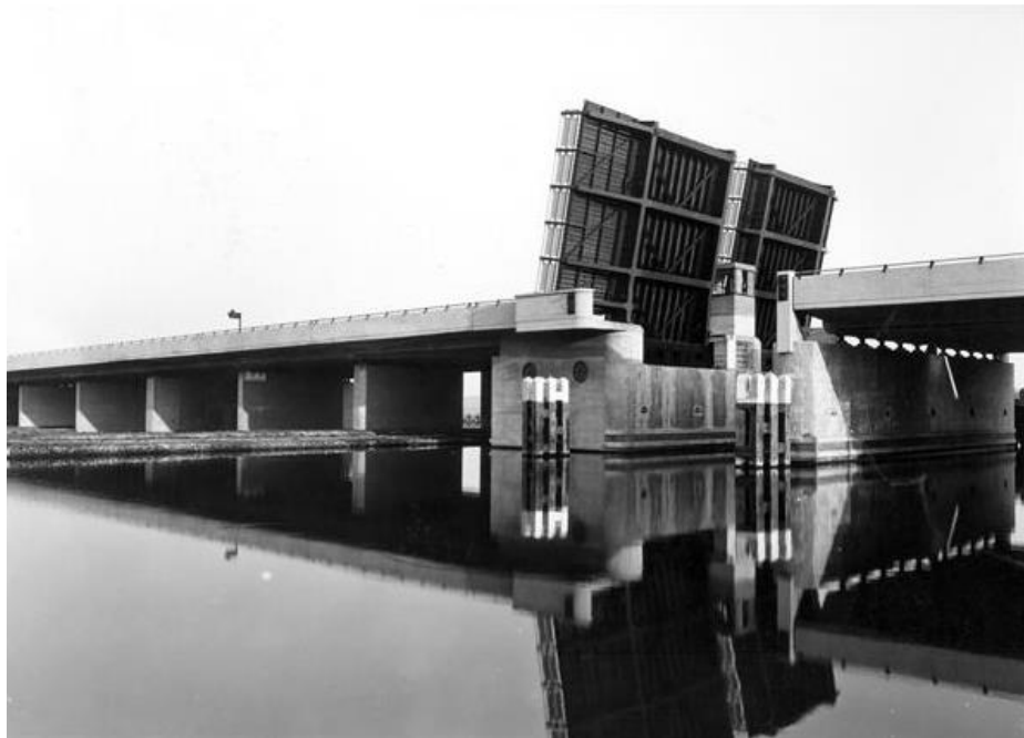
Kaagbrug op een foto uit 1939 over de Zuidelijke Ringvaart bij Sassenheim met de twee rolbasculebruggen met Panamawielen. RWS Beeldbank.
