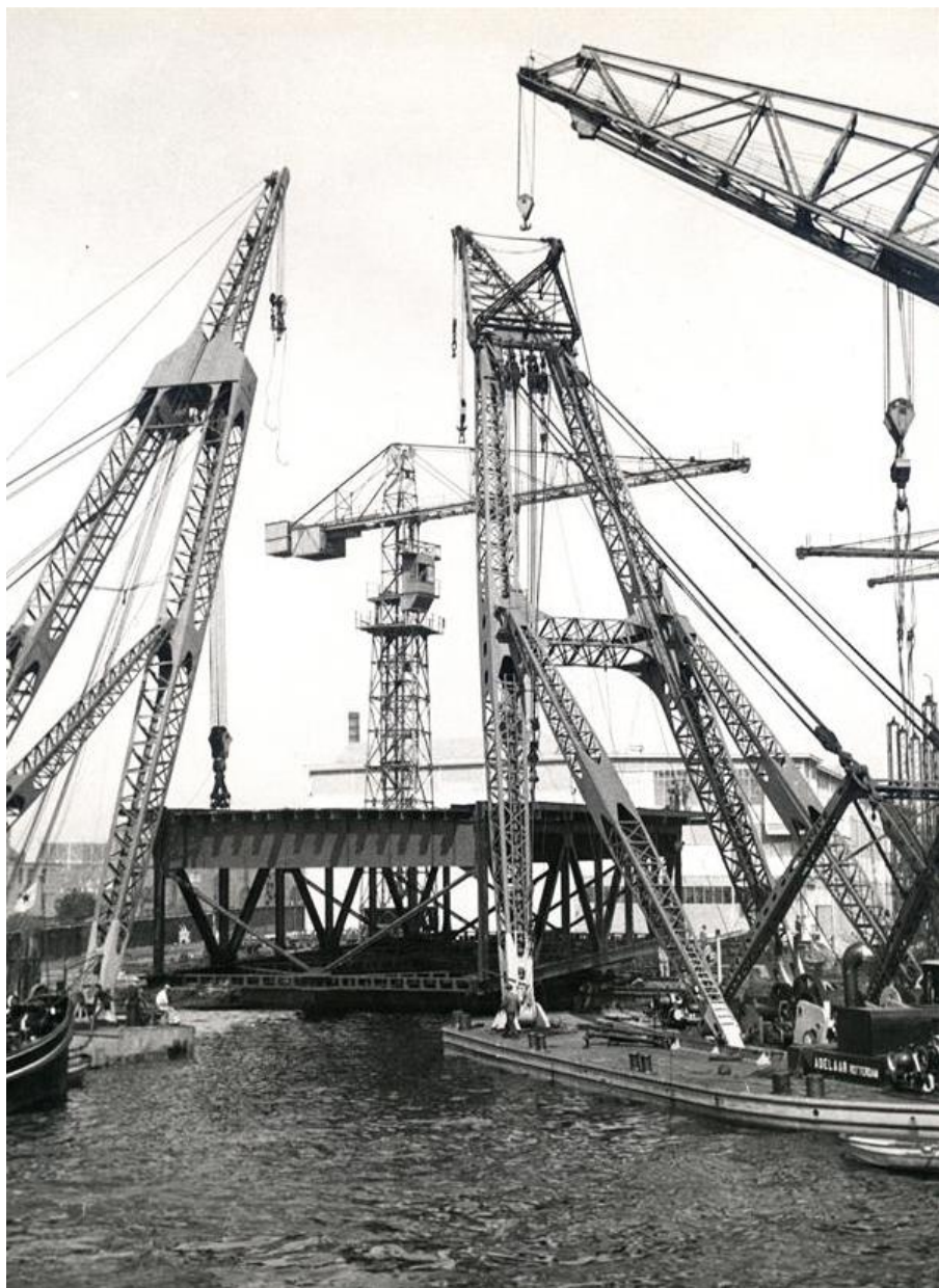
De plaatsing van het val geschiedde met veel drijvende kranen. RWS Beeldbank.
