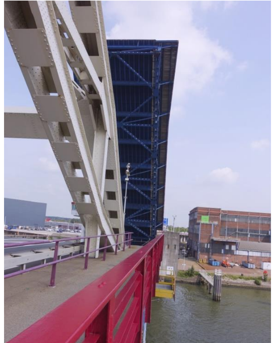
Het val in werking, waarbij een overspanning van 42 meter tot 60 meter hoog reikt.
