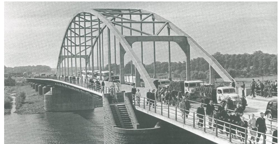
De IJsselbrug in Deventer (1943) was van het type verstijfde staafboogbrug, dat ook veel is toegepast bij de eerste bruggen over het Amsterdam-Rijnkanaal. Ook deze brug heeft fietspaden aan de buitenkant, zoals gebruikelijk in die periode. Het bovenwindverband bestaat hier uit een K-verband. Uit: Bruggen in Nederland 1800-1940 Vaste bruggen van ijzer en staal.
