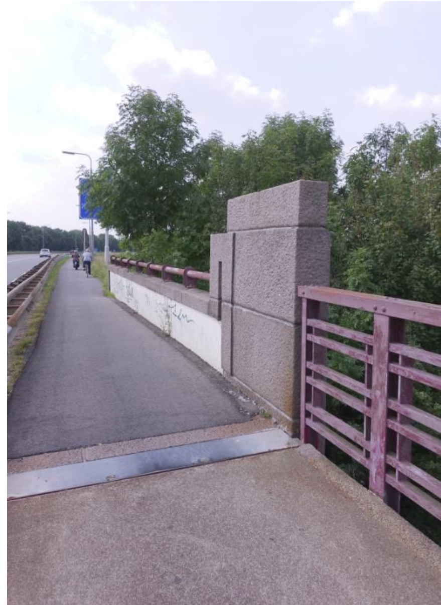
De borstwering van het landhoofd is op dezelfde manier afgewerkt als aan de overzijde bij de kelderpijler.
