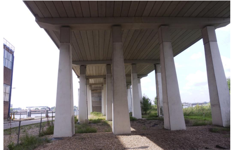
Zicht op de reeks betonnen funderingspalen die ten oosten van de kelderpijler zijn gesitueerd. Het wegdek is van beton.
