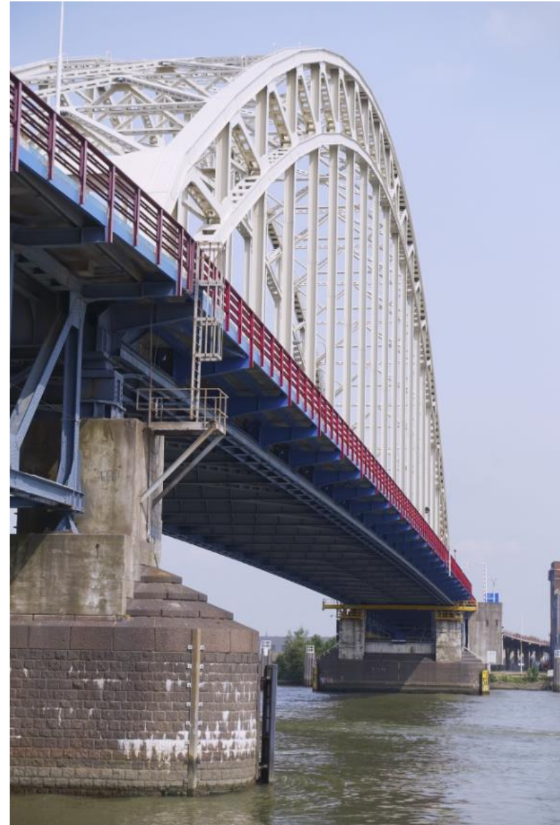
Zicht op de zuidzijde van de brug, gezien richting het noordoosten.
