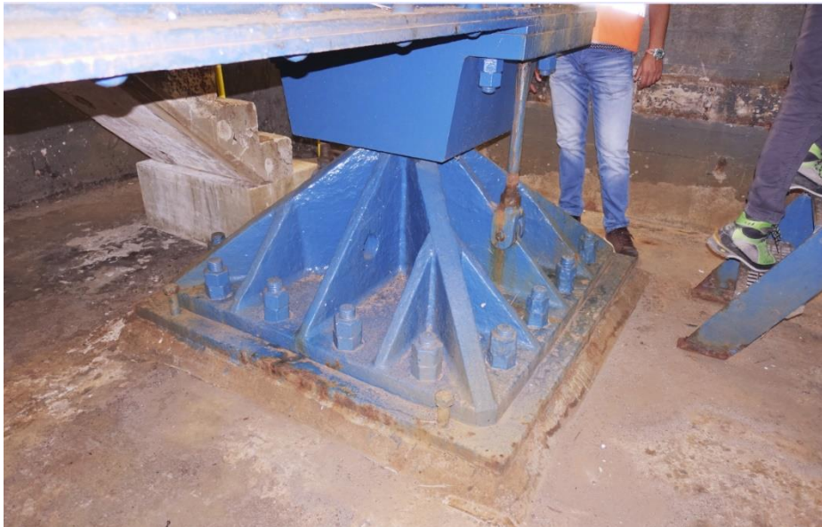
Detail van de scharnieroplegging van de noordelijke rolbaan.
