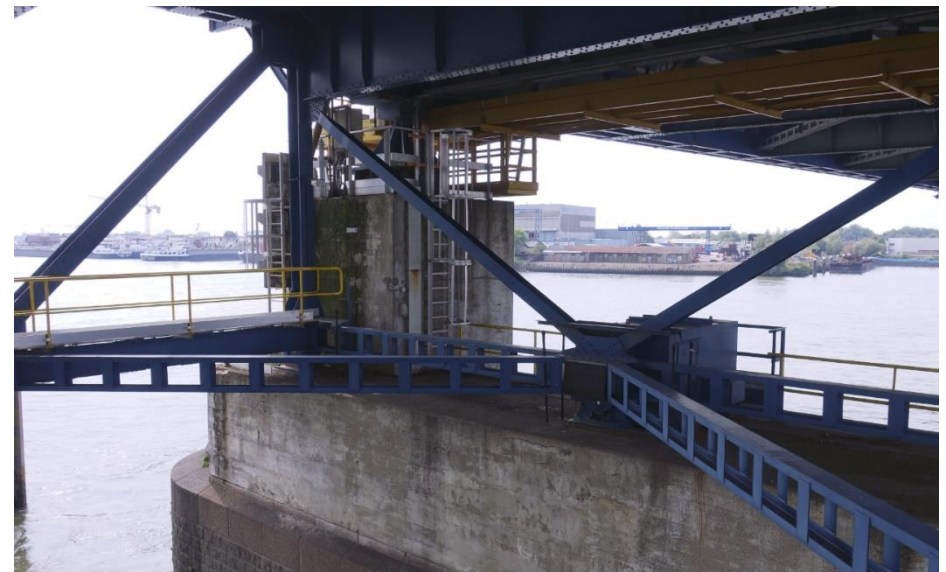
Het uiteinde van het val rust op een oplegging op de oostelijke pijler.
