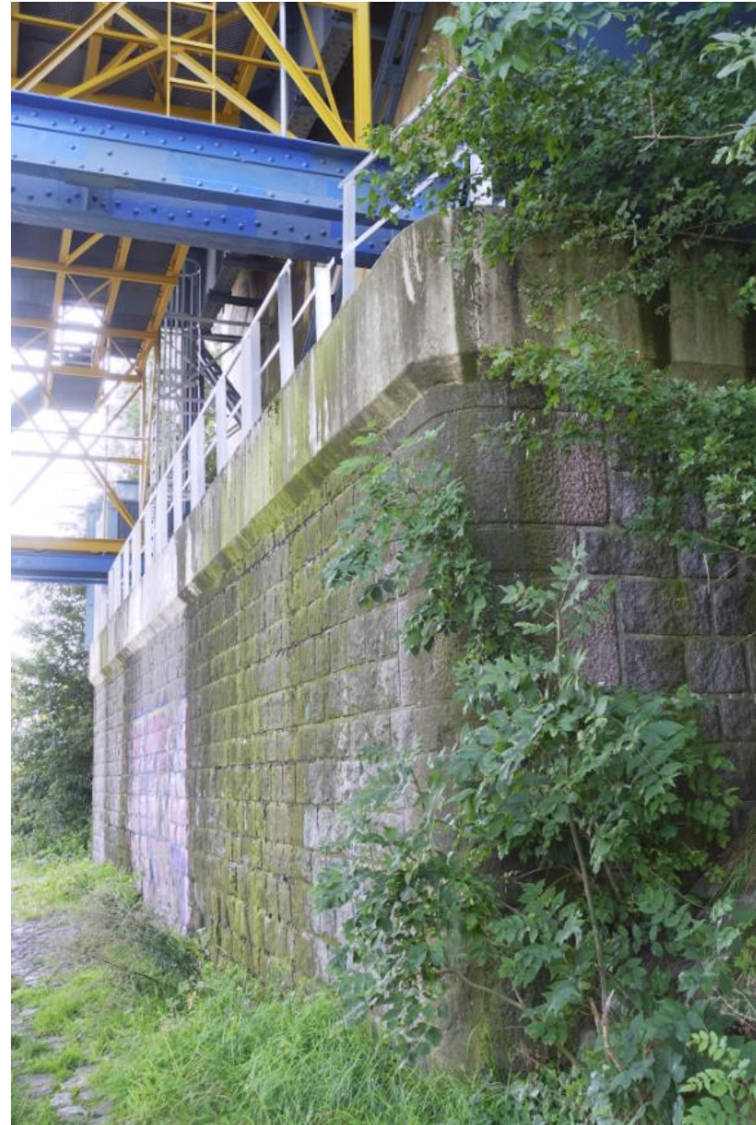
Zicht op het landhoofd aan de westzijde van de brug.
