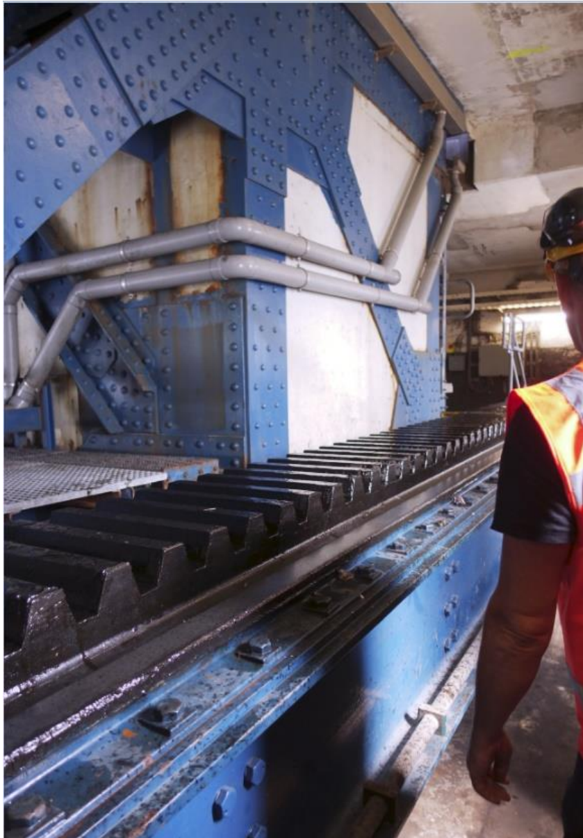
Zicht op de zuidelijke tandradbaan waarover de elektromotor zich naar achteren trekt, waardoor het contragewicht begint te zakken.
