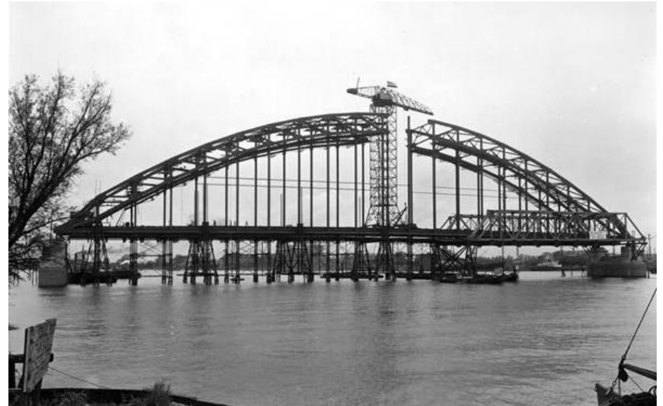
Het bovenste deel van de hoofdo overspanning wordt gedicht in oktober 1938. RWS Beeldbank.
