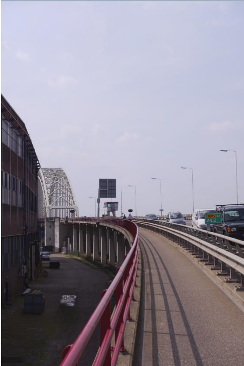
De oostelijke oprit gezien naar het westen.
