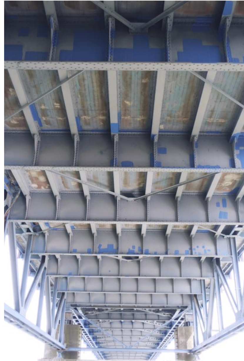
Zicht op de dekconstructie van de aanbrug, die geen onderwindverbanden heeft.
