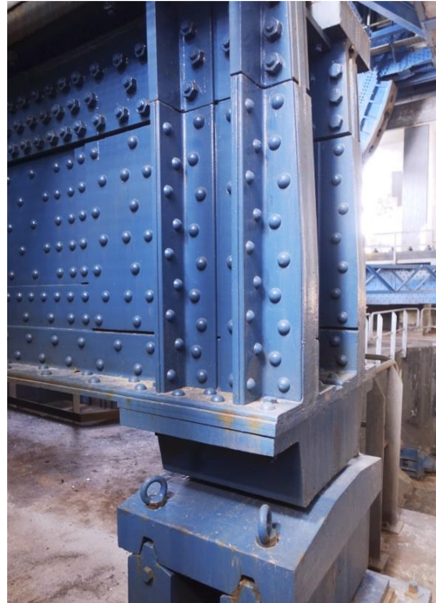
Detail van de scharnieroplegging van de noordelijke rolbaan. De bovenzijde van de rolbaan is in 1985 vervangen, duidelijk herkenbaar aan de aanwezige bouten i.p.v. klinknagels.
