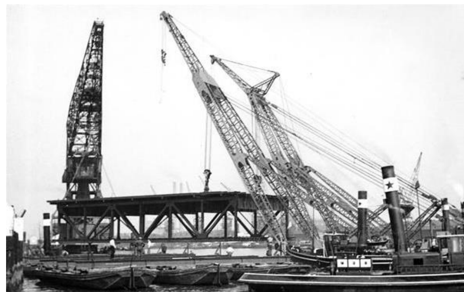
De plaatsing van het val in 1939, gezien vanuit een andere hoek. RWS Beeldbank.
