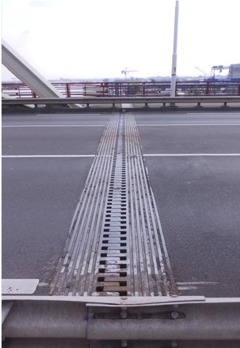
Detail van de stalen voegovergang tussen oprit en aanbrug, aan de westzijde van de brug.
