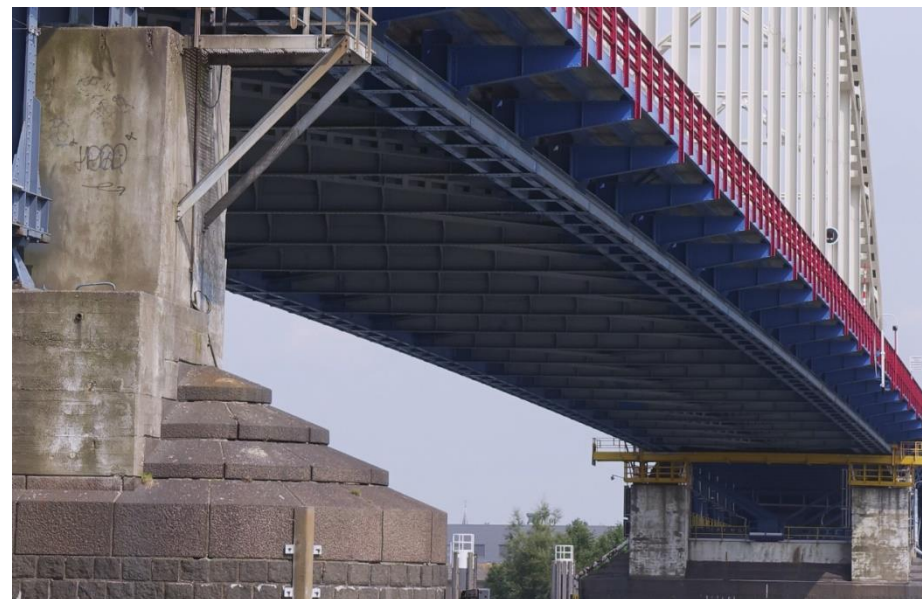
Detail van de dekconstructie van de hoofdo overspanning, met aan de buitenzijde het fietspad op ijzeren consoles. Rechts op de foto is de geel geverfde baan met verfwagen zichtbaar.
