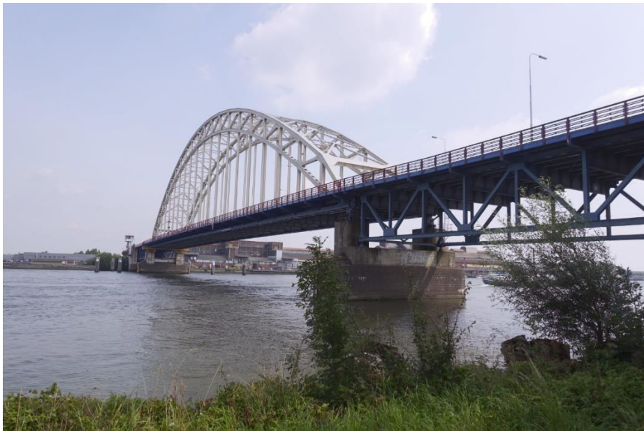
Zicht op de brug, gezien richting het zuidoosten. Links is de aanbrug gesitueerd.
