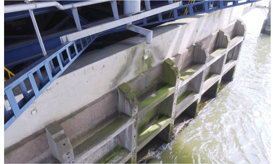
Het onderstel deel van de kelderpijler is aan de waterkant voorzien van een houten frame.
