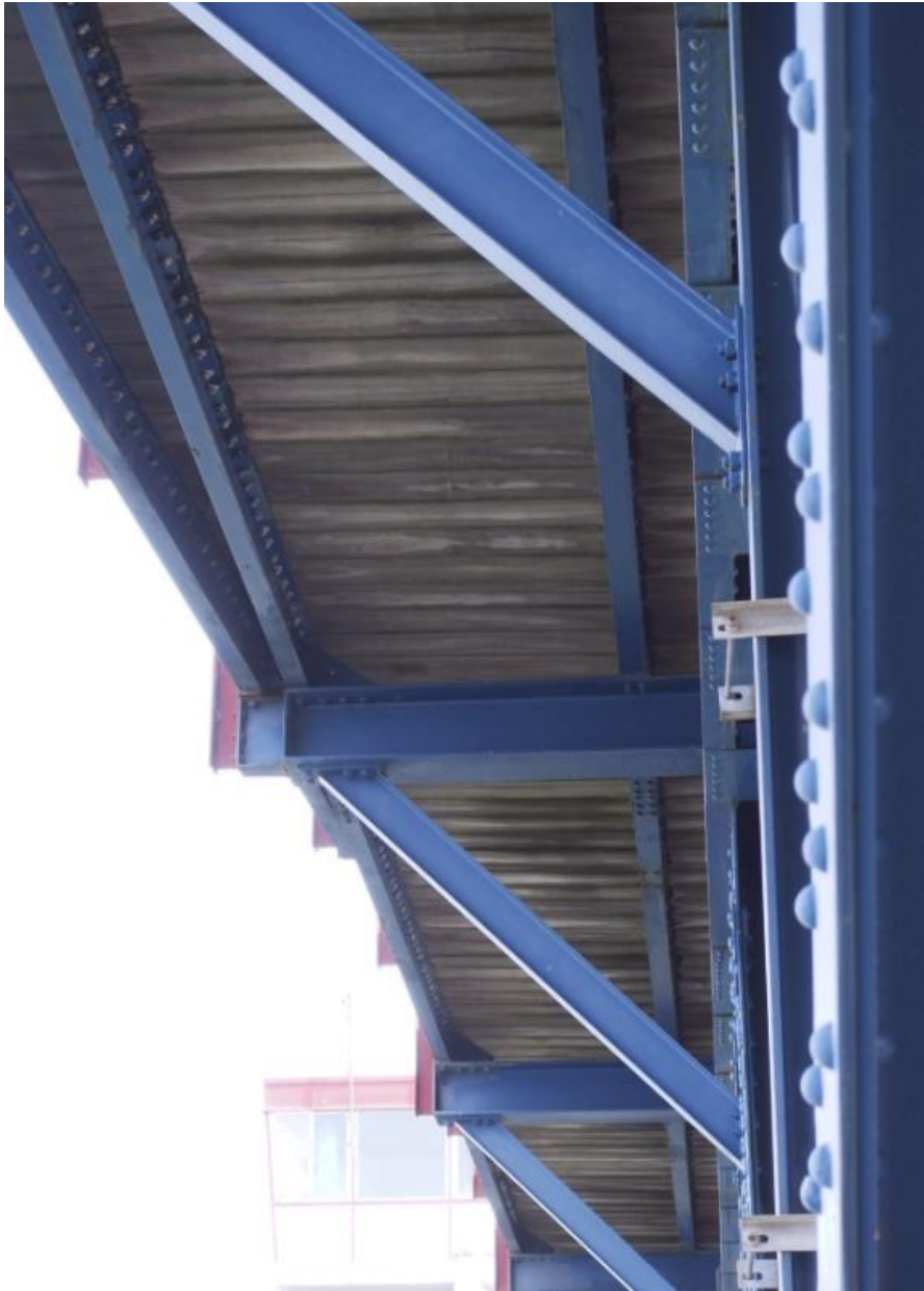
Het dek bij de fietspaden bestaat uit houten liggers.
