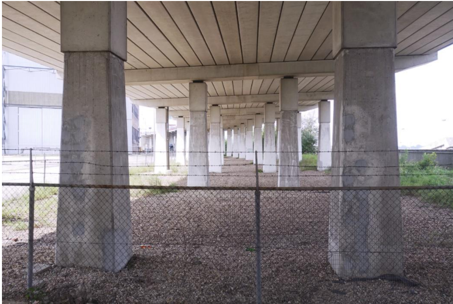
Zicht op de betonnen palen die de verhoogde oostelijke oprit van de brug dragen. Het bovenste deel van de palen is recentelijk voorzien van nieuwe koppen.
