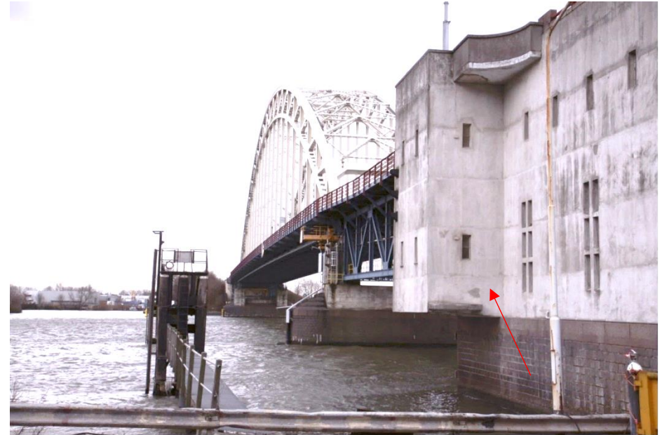
Zicht op de zuidzijde van de betonnen kelderpijler aan de oostzijde van de Noord. Het trappenhuis onder het oorspronkelijke brugwachtershuis op overhang had een stalen lichtpui, die in 1972 is gesloopt (rode pijl). foto: alblassernews.nl , 23 januari 2012.
