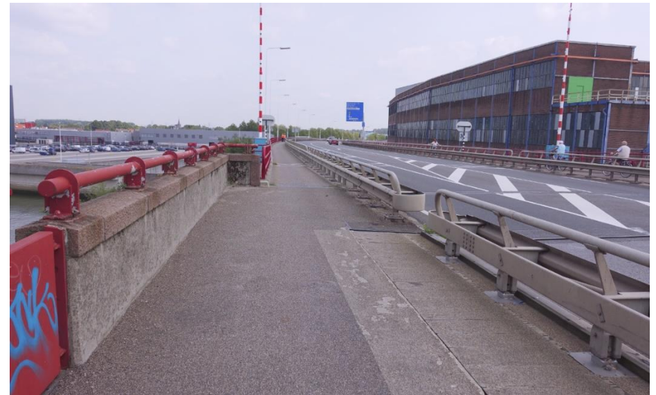
Ter plaatse van de oostelijke kelderpijlerzwenken de fietspaden wat uit.
