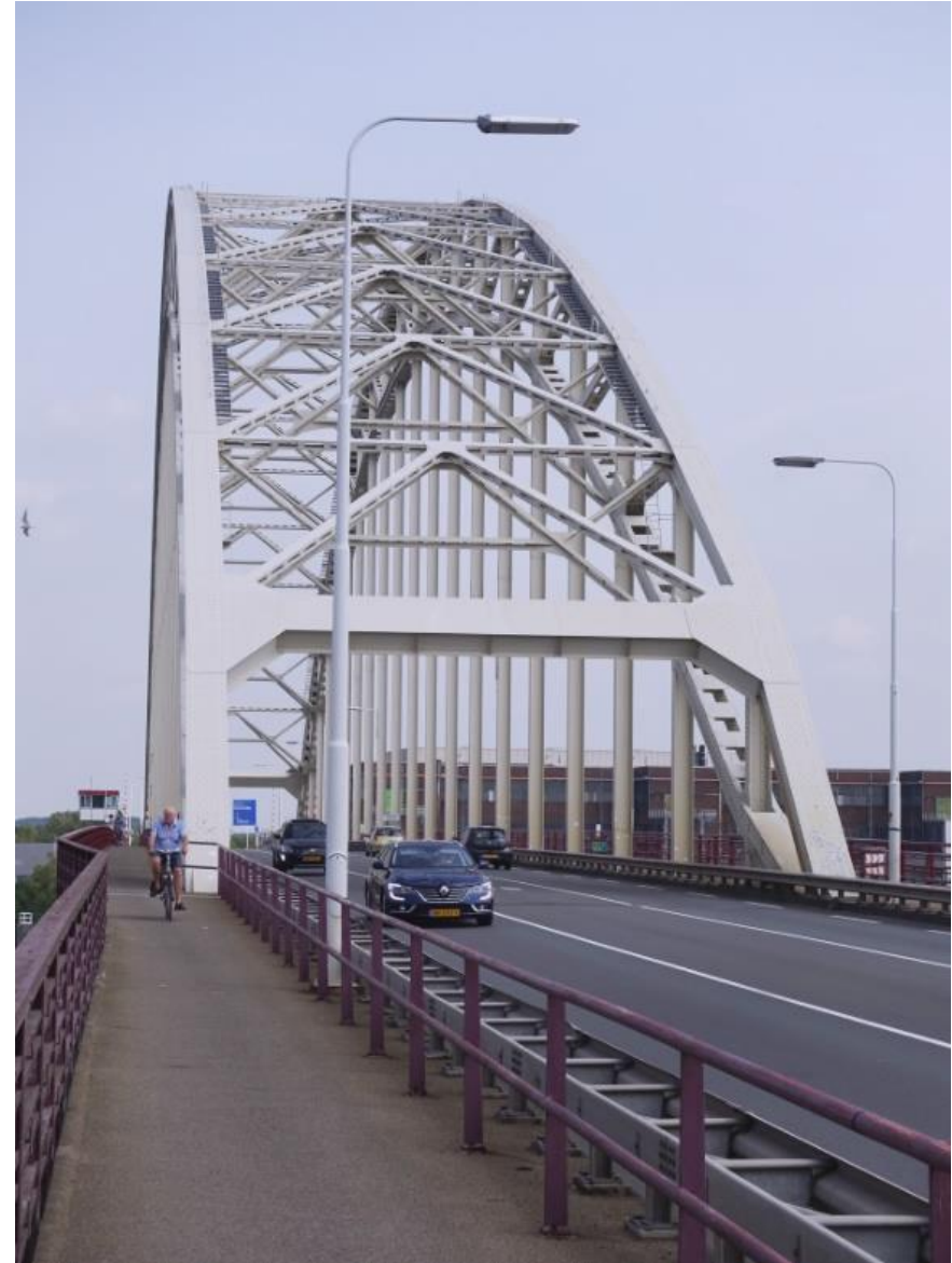
Het portaal aan de westzijde heeft een veel zwaardere constructie dan de overige dwarsverbanden. De bovenliggende K-verbanden zijn duidelijk zichtbaar op deze foto.
