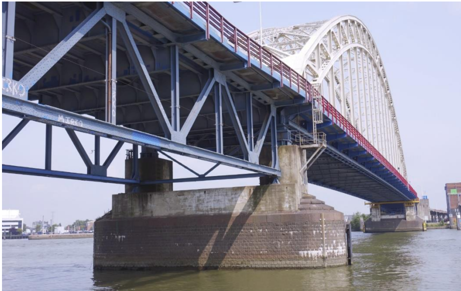
Zicht op de zuidelijke kant van de aanbrug, waarbij de vakwerkliggers duidelijk zichtbaar zijn.
