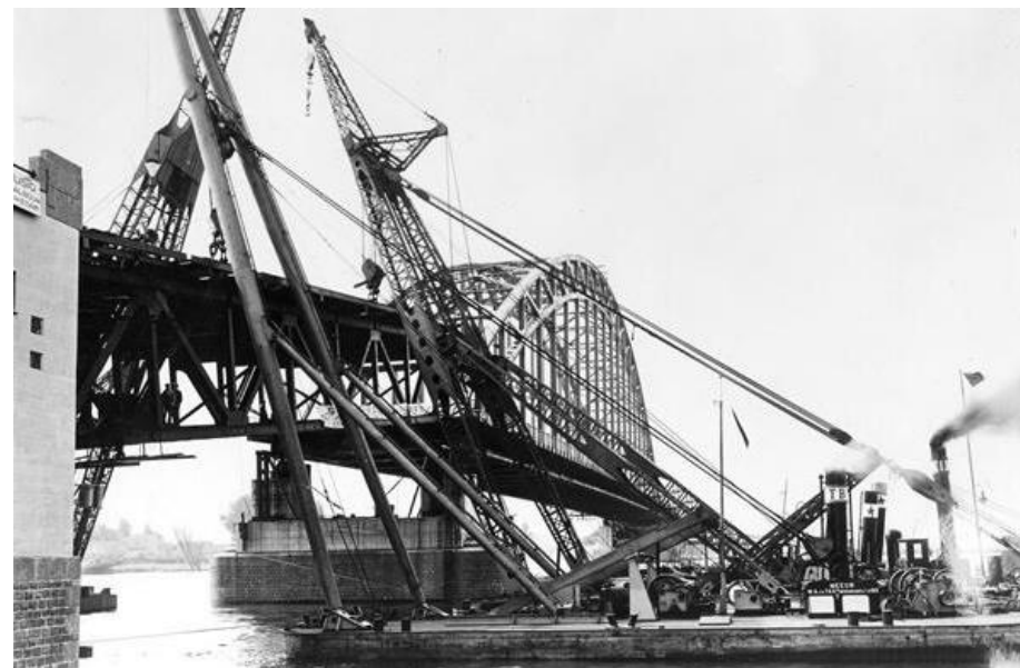
De rolbasculebrug ligt bijna op zijn plek. RWS Beeldbank.
