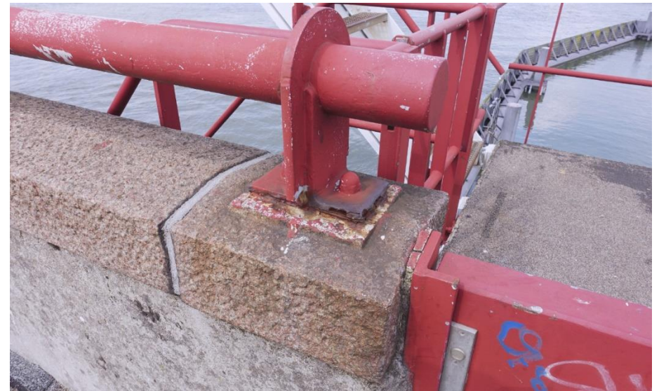
De borstwering van de kelderpijler heeft deels een stalen hekwerk op granieten dekstenen.
