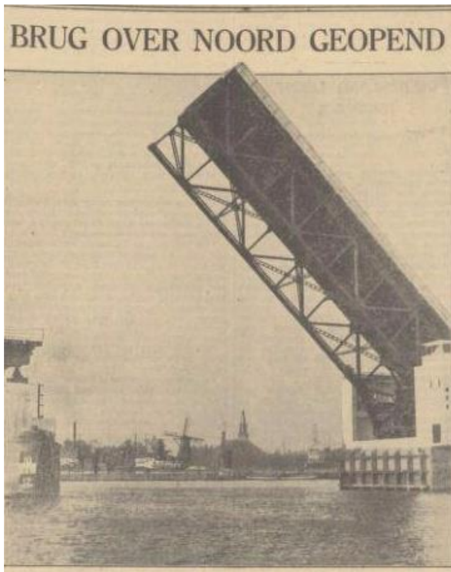
Zicht op de rolbascule, gezien vanaf het water richting het noorden. De constructie van de onderzijde van het val is goed zichtbaar op deze foto. Algemeen Handelsblad 14-11- 1939. bron: delpher.nl.
