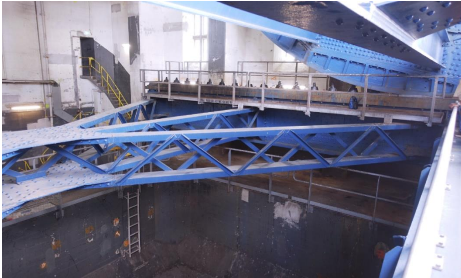
Zicht op de zuidelijke rolbaan met op de voorgrond het stervormige stabiliteitsverband.
