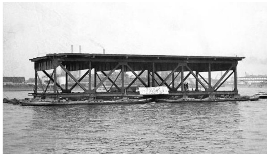
Een deel van het brugklapgedeelte is vanaf Schiedam ingevaren, hier zichtbaar op een foto uit juli 1939. RWS Beeldbank.
