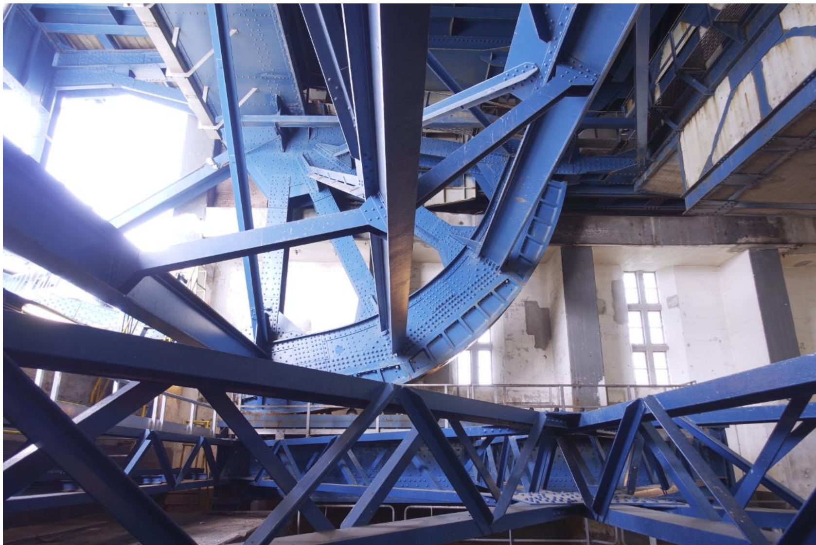
De huidige situatie waarbij de stabiliteitsaanpassingen van stalen profielen en vakwerkliggers uit 1985 duidelijk zichtbaar zijn.
