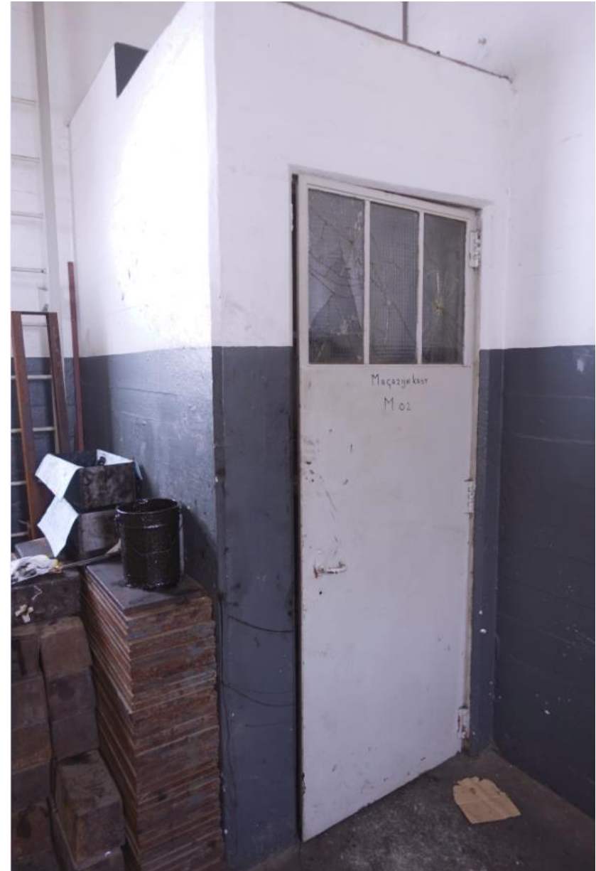
Tegen de zuidgevel is nog een oorspronkelijk berghok met stalen deur aanwezig.
