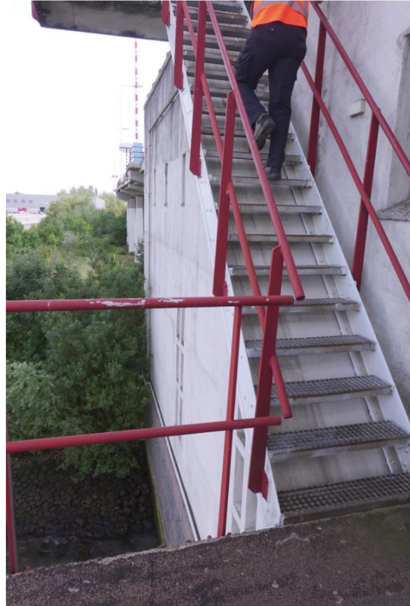
Stalen trappen met bordessen tegen de noordgevel van de kelderpijler.
