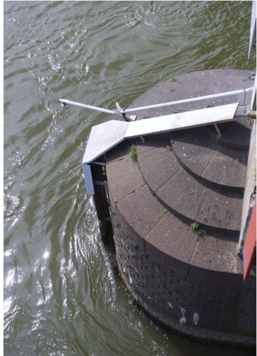
De zuidelijke kant van de oostelijke pijler, gezien vanaf de hoofdoverspanning.
