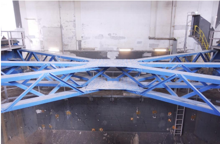
Detail van de zware schetsplaten die het stervormige verband tussen de beide rolbanen verbindt.
