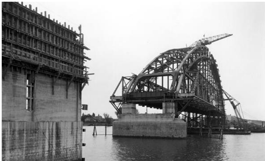
De betonnen kelderpijler is gedeeltelijk gestort terwijl de werkzaamheden aan de hoofdo overspanning vorderen, omstreeks oktober 1938. RWS Beeldbank.
