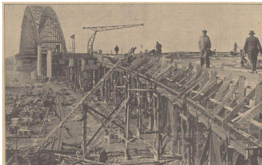
In de loop van de zomer van 1939 werd ook begonnen met de aanleg van de oostelijke oprit naar de brug. Aan de zijkanten van de oprit werden fietspaden aangelegd, die middels stalen hekwerken werden gescheiden van het wegdek. De Maasbode , 01-03-1939. delpher.nl.
