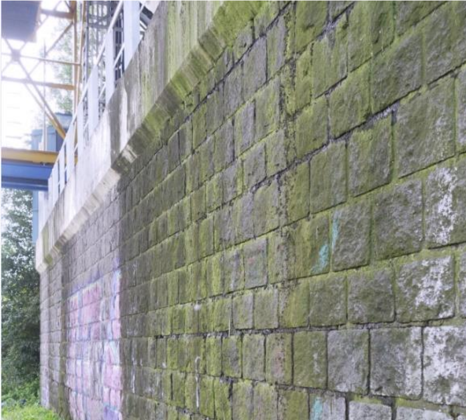
Detail van de bekleding van basalt en graniet bij het landhoofd.
