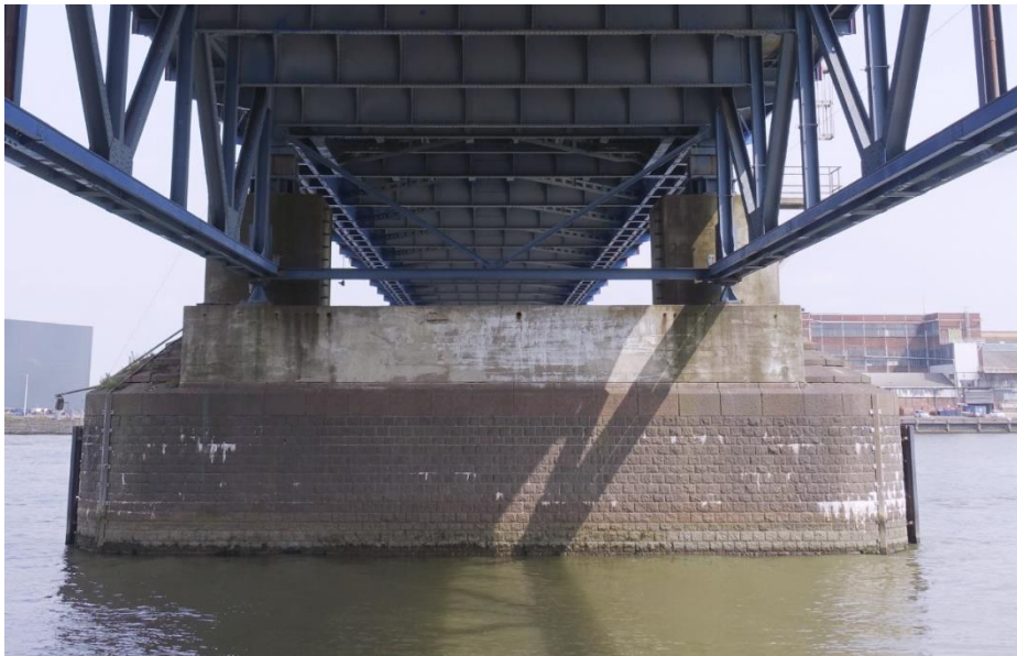
De westelijke pijler, gezien vanaf de westelijke oever.
