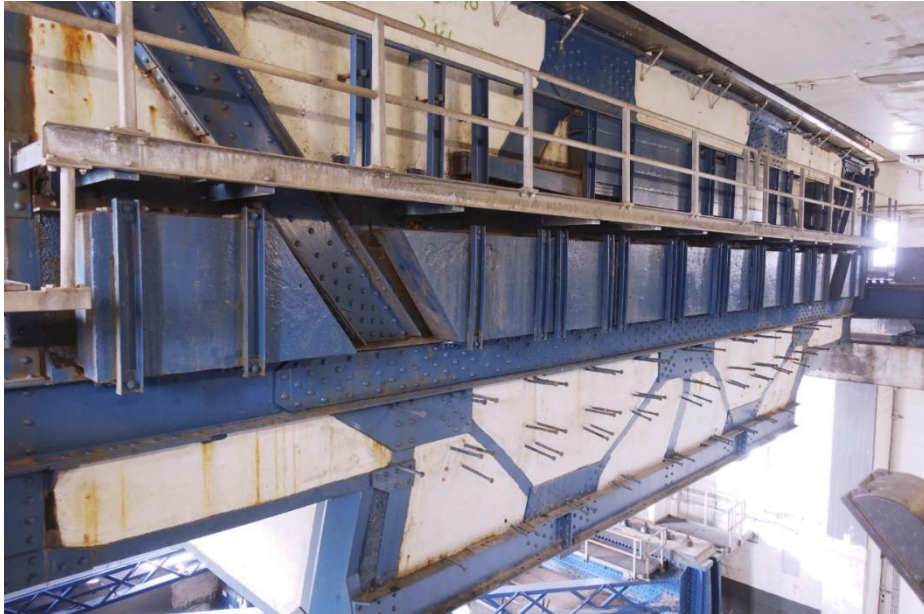
Detail van de achterzijde van het contragewicht. De pinnen in het beton zijn aangebracht voor het ophangen van extra ballast.
