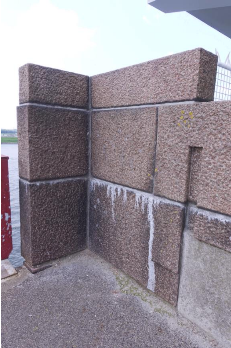
Verhoogde borstwering van graniet boven de oostelijke kelderpijler.
