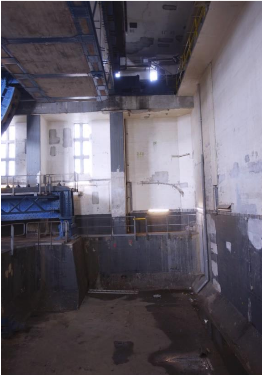
Zicht op de achterste helft van de kelder, die een dieper kelderniveau heeft vanwege het contragewicht dat hier naar beneden zakt.
