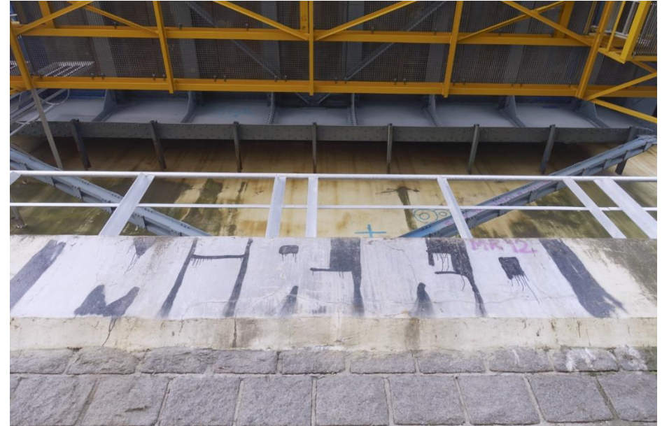
Zicht op de omgang aan de bovenzijde van de plint bij het westelijke landhoofd.
