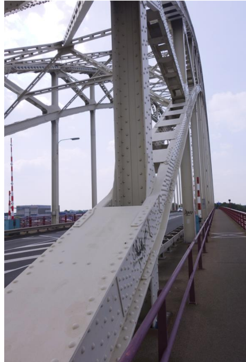
Detail van de oostelijke aansluiting bij het wegdek van de onderste boog aan de noordzijde van de brug.
