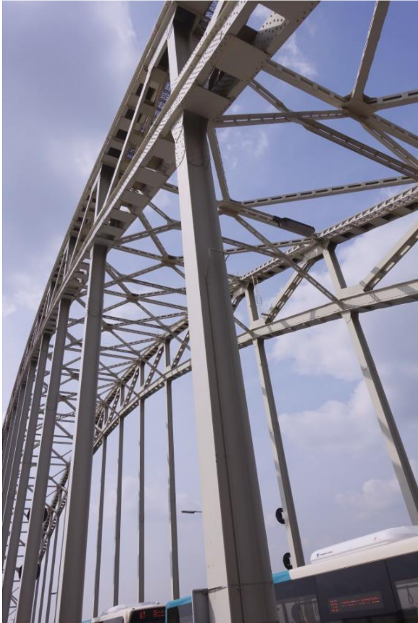
Detail van de hangers van de boogbrug.
