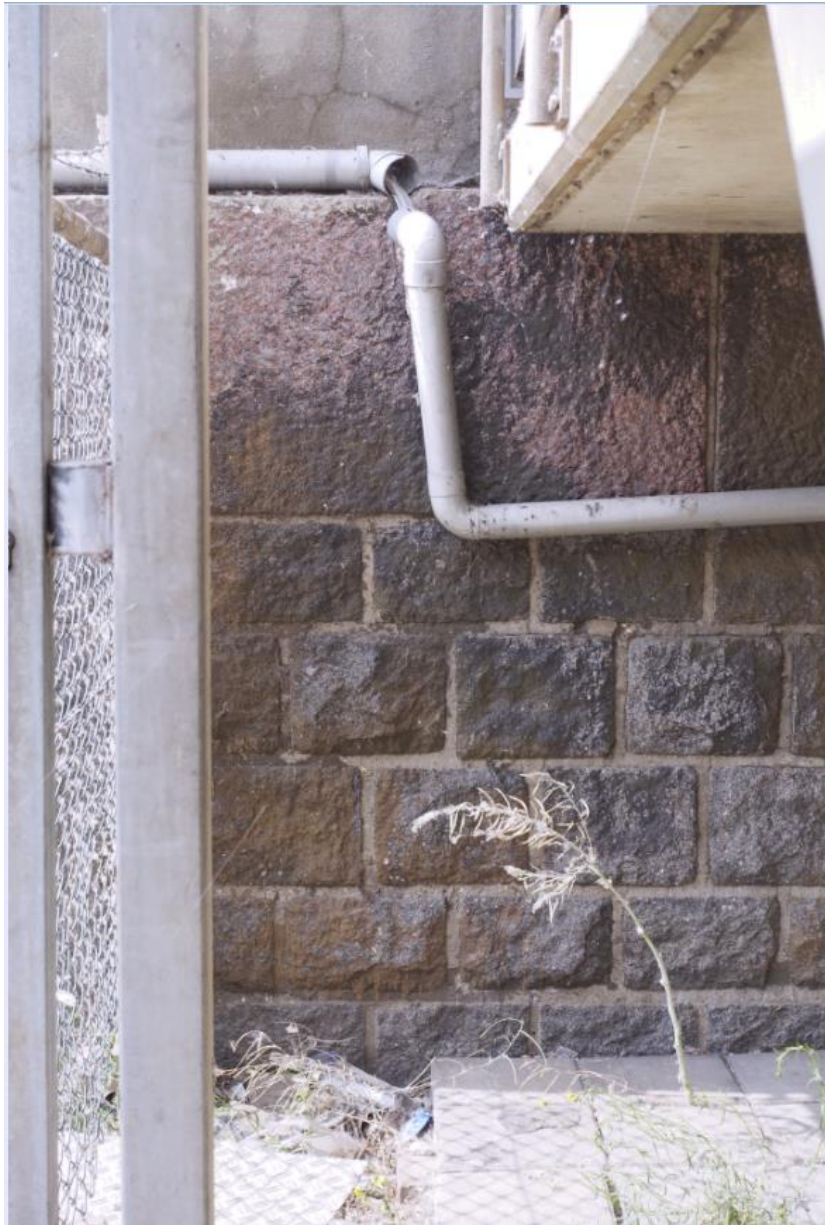
Detail van de plint van de kelderpijler, waarin basalt en graniet zijn gebruikt.
