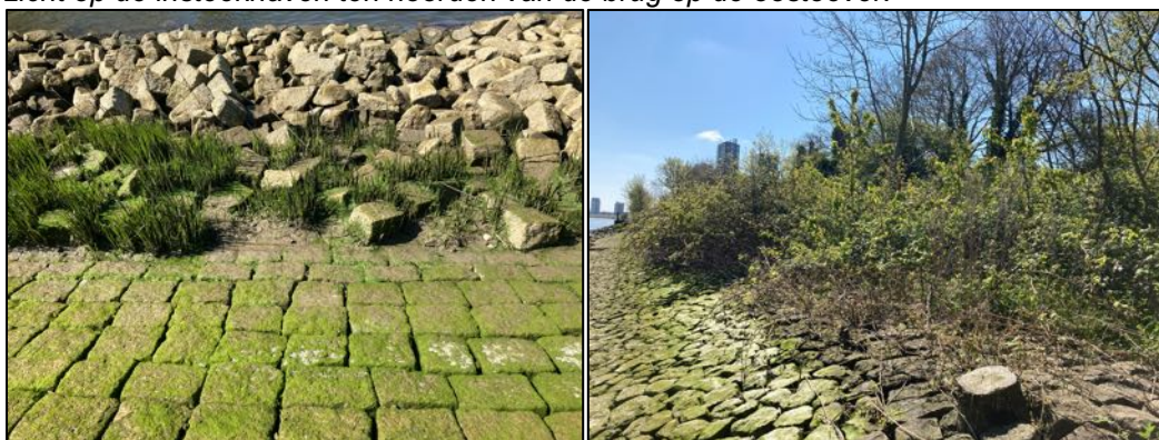
Impressie van de westoever van de Spijkenisserbrug. Links zicht op de oeververharding en steenbestorting met daartussen enige begroeiing (geen beschermde soort). Rechts zicht op de beplanting ten zuiden van de brug.
