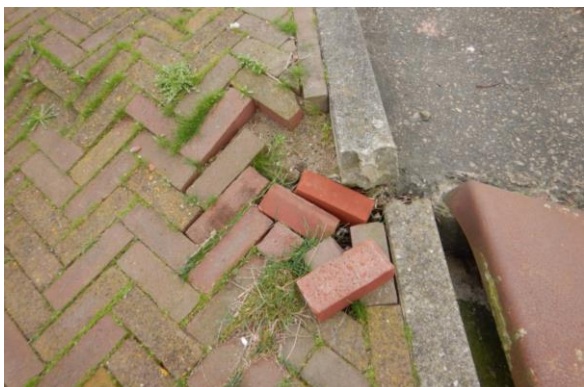
Afbeelding 18: Einde damwand deel 3 oorspronkelijke situatie
