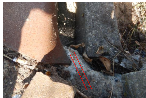
Afbeelding 19: Verplaatsing damwand deel 3 na ontgraven
