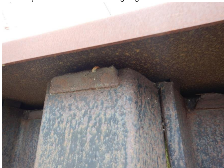
Figuur 12 - Dekslloof op damwand
