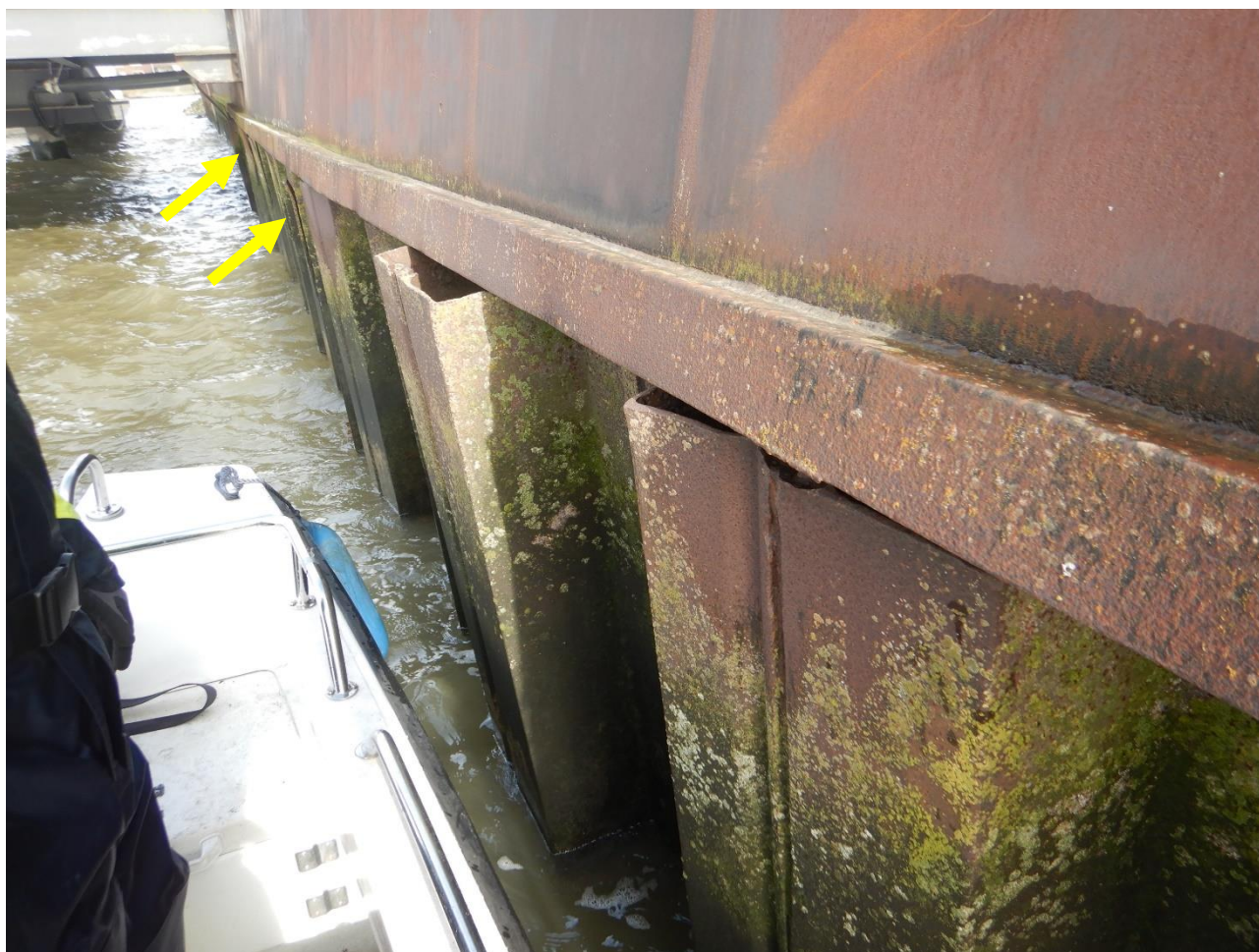
Figuur 11 – Verplaatsing en uitbuiking in damwandlijn: Bron: [A]
