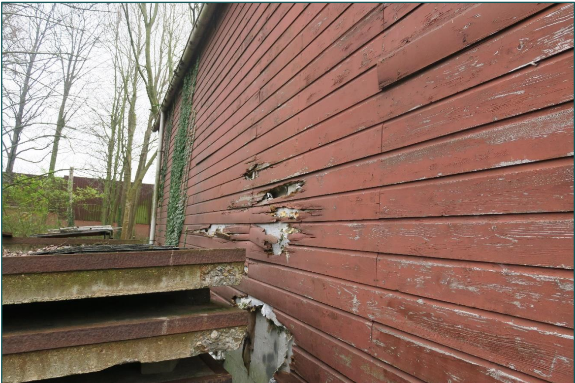
Figuur 2 De bebouwing bestaat uit stenen muren met gepotdekselde planken gemonteerd. Teven is er een isolatie aanwezig.
