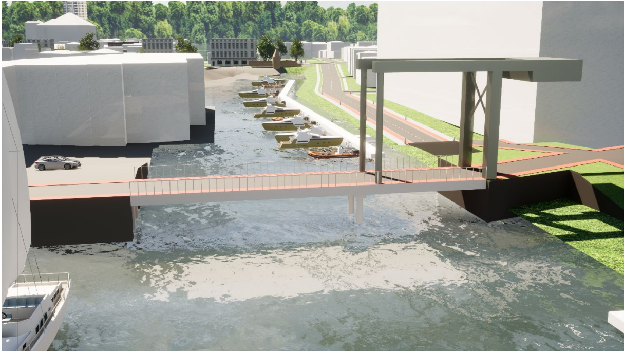
Figuur 14: Nieuwebrug bij OceAnco
