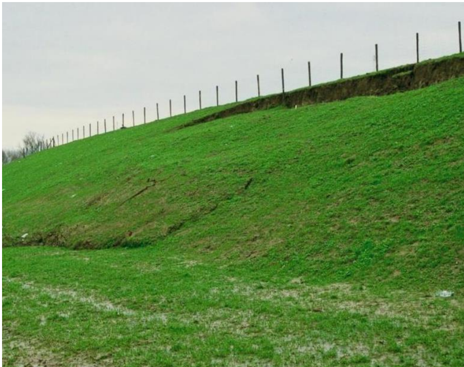
Figuur 36 schade door wegzakken grond
