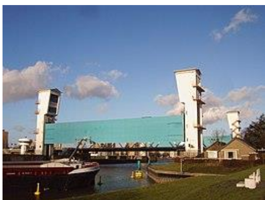
Figuur 23 Keersluis met hefdeur, Hollandse IJssel
