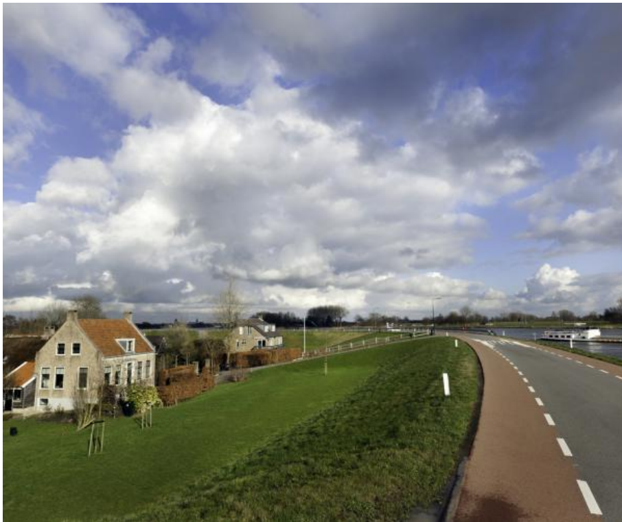
Figuur 37 Kering met geasfalteerd wegdek
