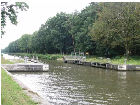
Figuur 22 Keersluis met puntdeuren, Ravels
