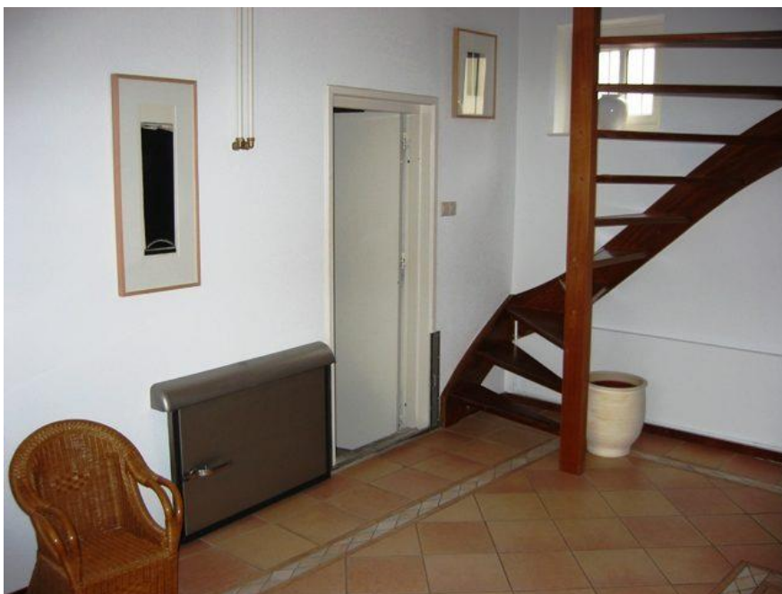
Figuur 6 Handmatige waterkering Kampen
