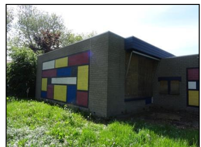
Figuur 5. Overzicht zuidoostelijke zijde van het gebouw.
