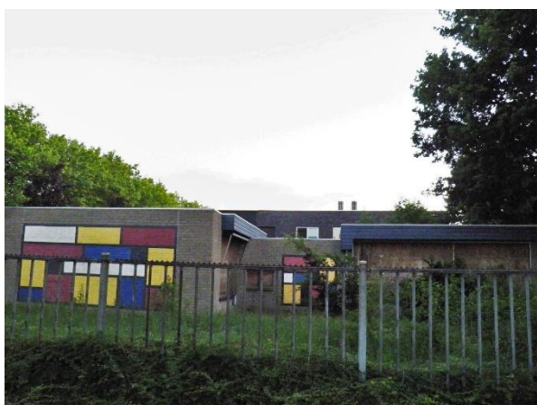
Foto 1. Aanzicht van de voormalige school vanaf de Esdoornlaan (22-06-2020).
