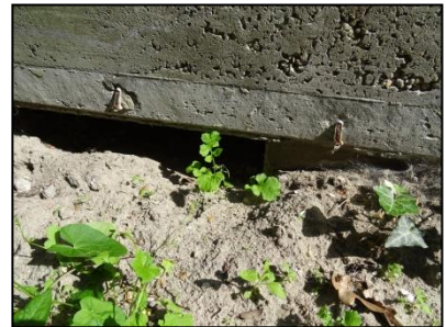
Figuur 11. Toegang tot ruimte onder de fundering.
