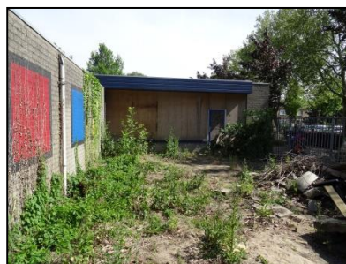
Figuur 4. Betegeling westzijde van het gebouw. Het aanwezige puin op het terrein is rechts op de foto te zien.
