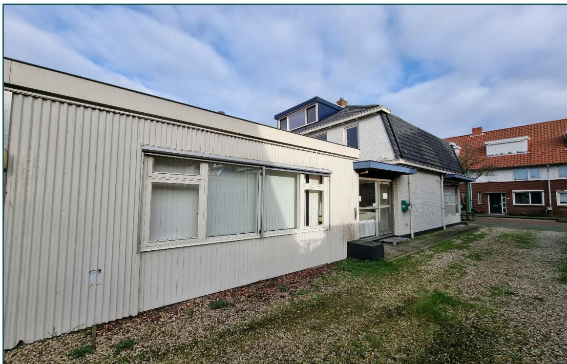
Figuur 2 Het linkerdeel van het bedrijfspand wordt gesloopt in de beoogde ontwikkeling.
