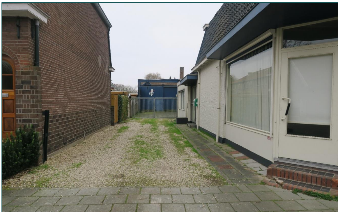
Figuur 1 De planlocatie is gelegen achter de Fop Smitstraat 48 te Alblasterdam en bestaat uit een loods en bedrijfspand. De beoogde ruimtelijke ingreep betreft de sloop van de loods en een gedeelte van het bedrijfspand
