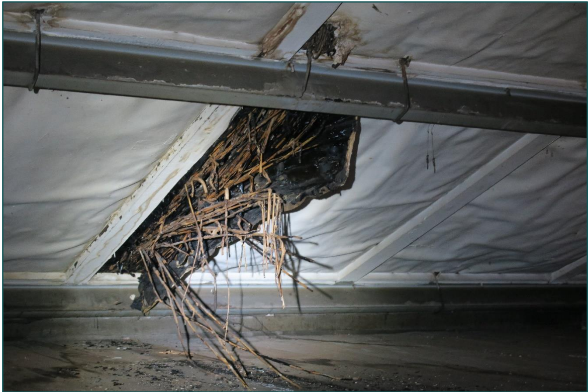
Figuur 3.1 Onder het dak van de loods zit een isolatie laag van stro en teer.
