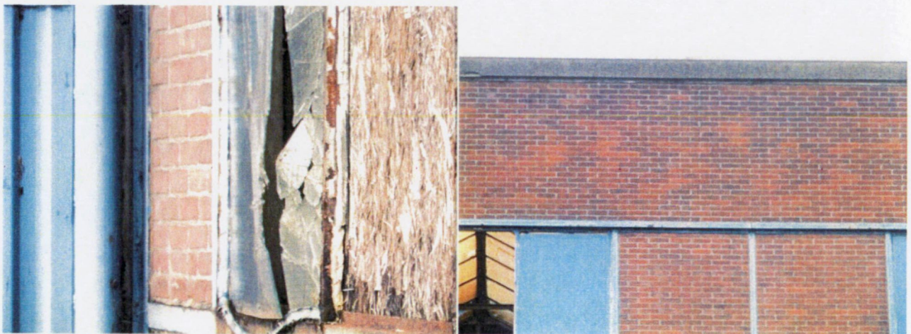
Afbeelding 6: Steensmuur zonder spouw.
