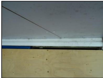
Figuur 9. Opening tussen plafond en betimmering bij de hoofdingang.
