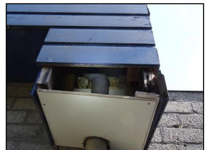
Figuur 8. Open boeiiboord door het ontbreken van de onderste plank van de betimmering, geeft toegang tot het boeiiboord.
