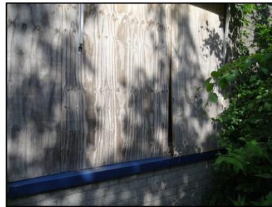
Figuur 10. Opening in de betimmering bij het raam aan zuidwestzijde van het gebouw.
