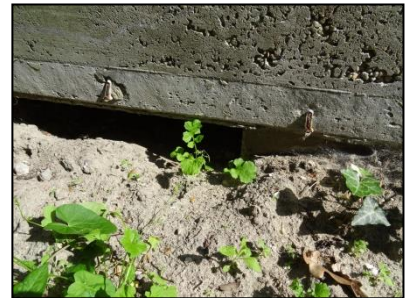
Figuur 11. Toegang tot ruimte onder de fundering.
