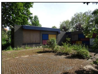
Figuur 3. Aanzicht noordzijde van het pand.
