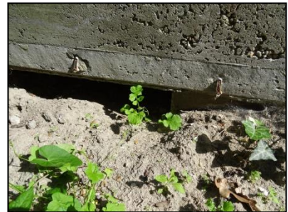
Figuur 11. Toegang tot ruimte onder de fundering.
