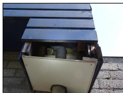
Figuur 8. Open boeiboord door het ontbreken van de onderste plank van de betimmering, geeft toegang tot het boeiboord.
