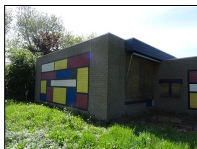
Figuur 5. Overzicht zuidoostelijke zijde van het gebouw.
