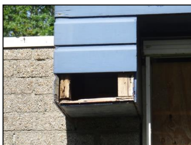
Figuur 7. Open boeiboord door het ontbreken van de onderste plank van de betimmering.
