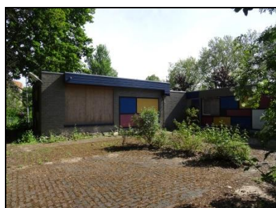
Figuur 3. Aanzicht noordzijde van het pand.
