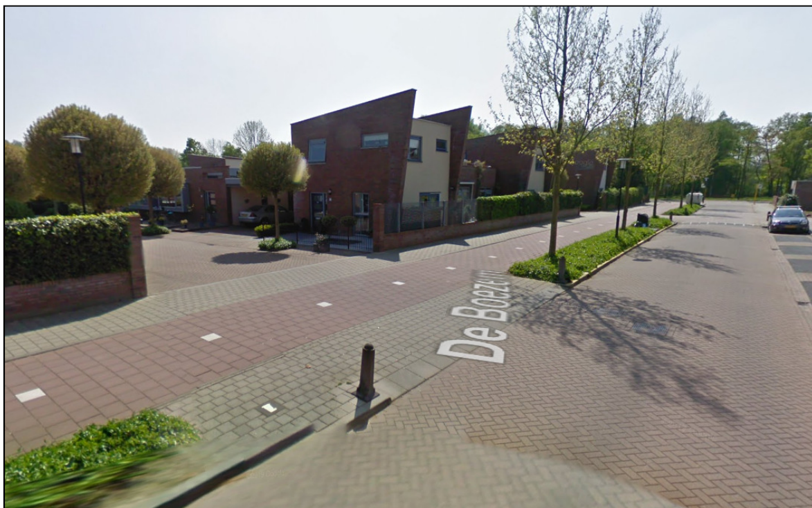
Figuur 3.3: Inritconstructie aan De Boezem met doorgaand fietspad
