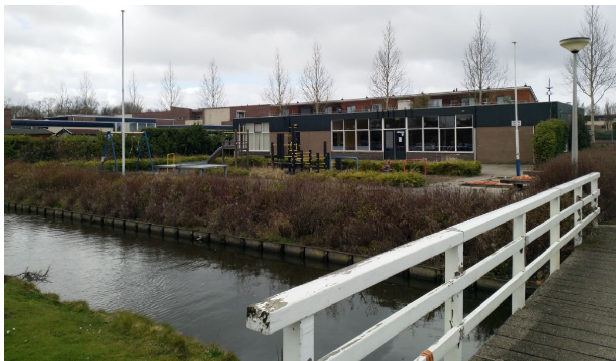
Afbeelding 3: zuidwestelijk deel van het plangebied gezien vanaf de toegangsbrug. Foto V. stuit | Ecoresult B.V.
