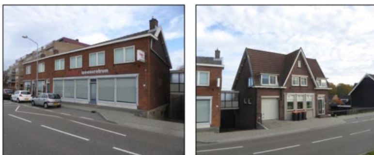
Foto's van de bestaande situatie
