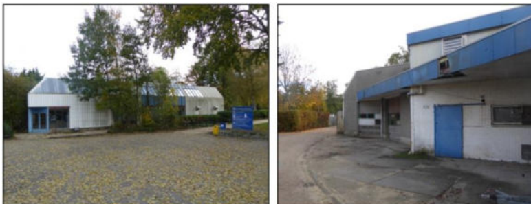
Foto's van de bestaande situatie
