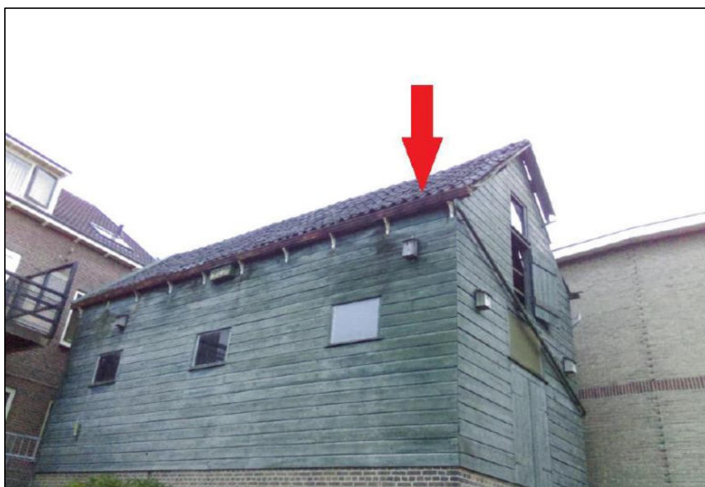
Locatie van de invliegopening van de gierzwaluwnestplaats op de Baas-locatie.
