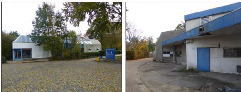
Foto's van de bestaande situatie
