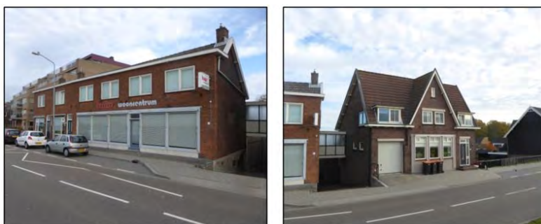
Foto's van de bestaande situatie
