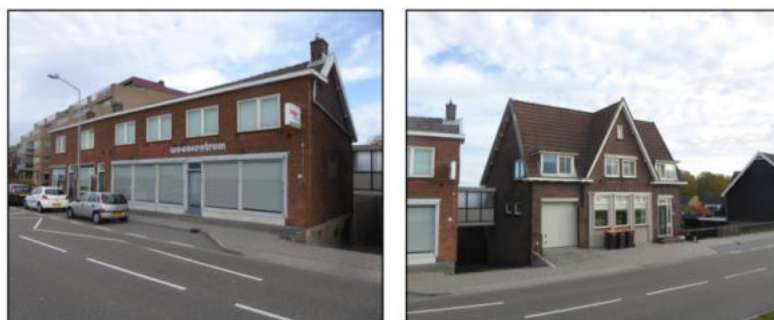
Foto's van de bestaande situatie
