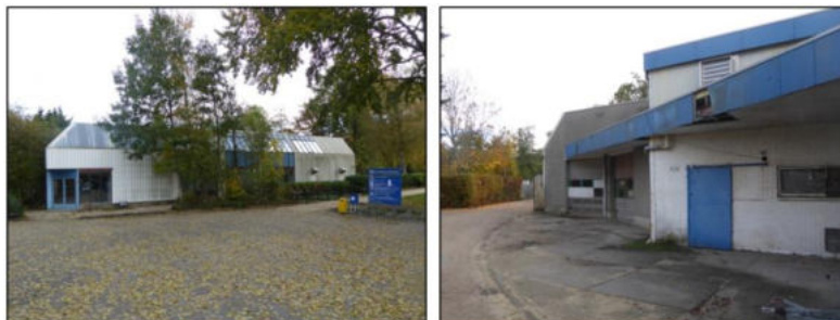
Foto's van de bestaande situatie
