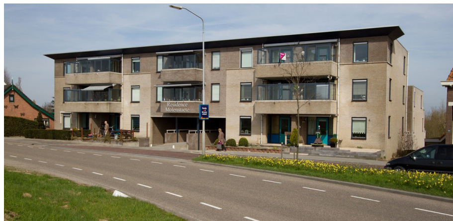
Afbeelding 5.9: Bebouwing aan de Noord die qua schaal en vormgeving contrasteert met de historische bebouwing aan het lint.
