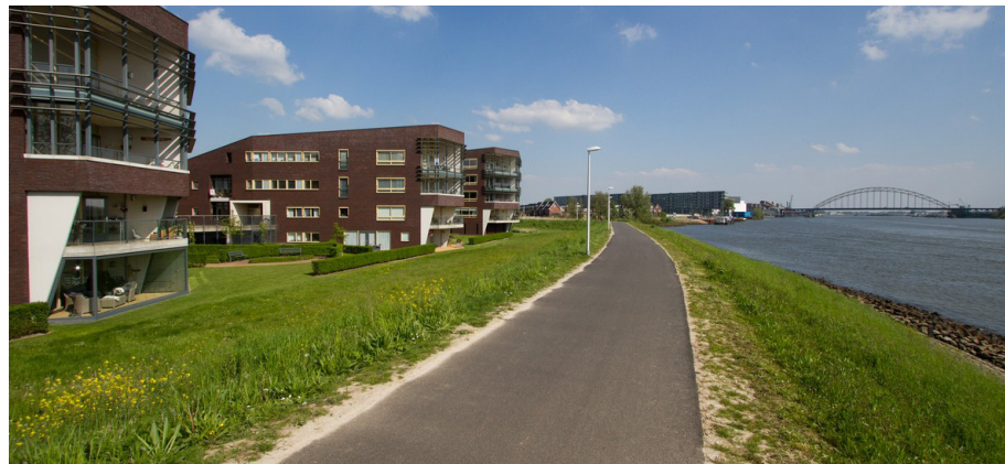
Afbeelding 5.8: Grootschalige nieuwbouw aan de Noord waarbij gezocht is naar een relatie met de rivier de Noord en de rol die de scheepsbouw speelt in het dorp.
