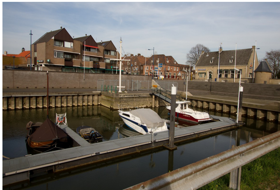
Afbeelding 2.15: Haven en de Dam met rechts het voormalige gemeenlandshuis. Links een in het dorpsbeeld voor wat de omvang en vorm van de bouwmassa betreft detonerend bankgebouw.
