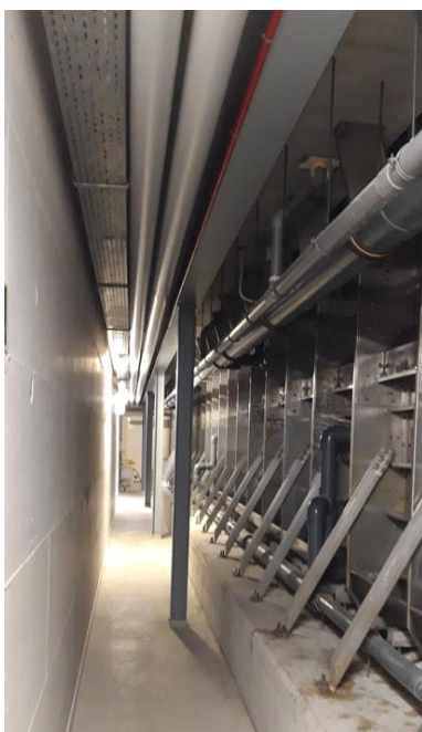
Figuur 1 - Overzicht van de roestvaststalen bassinwand
