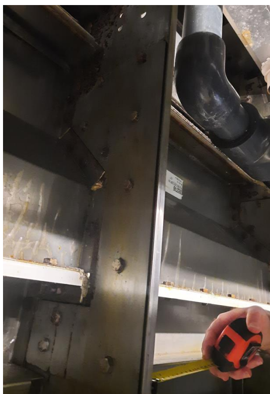
Figuur 8 - Versterking van de staanders met geboute platen
