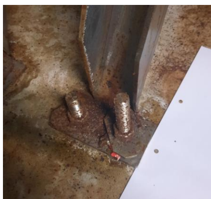
Figuur 5 - Opvallende corrosie nabij de trommelfilter
