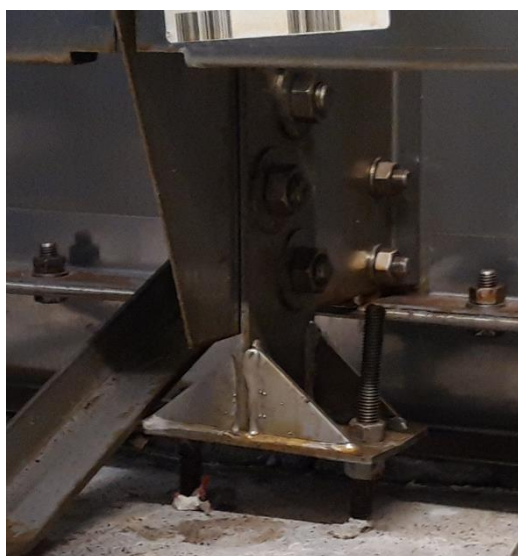
Figuur 7 - Aansluiting staander met de begane grondvloer
