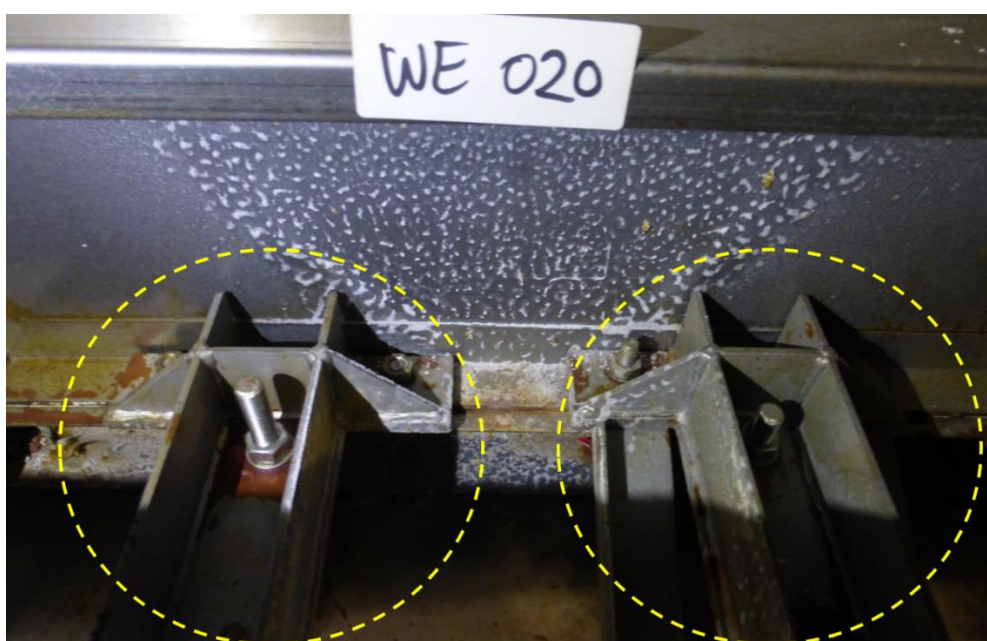
Figuur 3. Beide foto's: Boven op de hoeklijn waren relatief dikke constructieve elementen geplaatst met een (chemische) bout-verankering in de vloer op enige afstand van het U-profiel. Met als doel de wand naar beneden te drukken en de zijwaartse kracht van het water op de wand op te vangen. De gele pijl in de bovenste foto boven toont een van de voetstukken waar de verticale ribben op steunen. De boven getoonde constructieve elementen evenals het voetstuk waren in alle vakken gemaakt van een rvs materiaal type 304.
