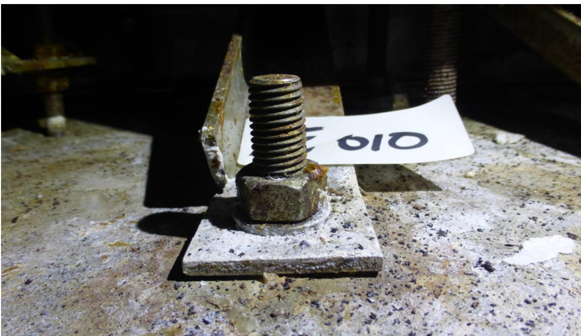
Figuur 12. Eén van de grondankers in vak AE-010 elke voor onderzoek in laboratorium is uitgehaald. (Hier nog in positie.)
