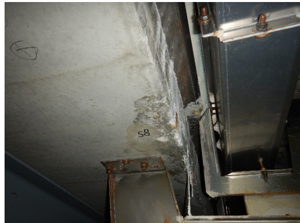
Foto 6.10: Overzichtsfoto onderzoekslocatie S8.
