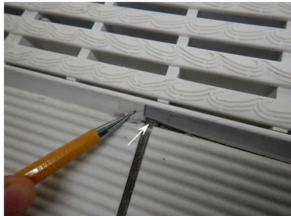
Foto 3.31: Aansluiting (nieuwe) herstelde kitvoeg op onthechte kitvoeg.
