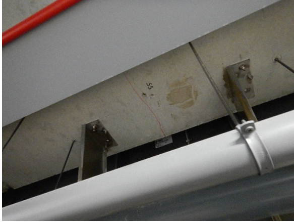
Foto 6.7: Overzichtsfoto onderzoekslocatie S5.
