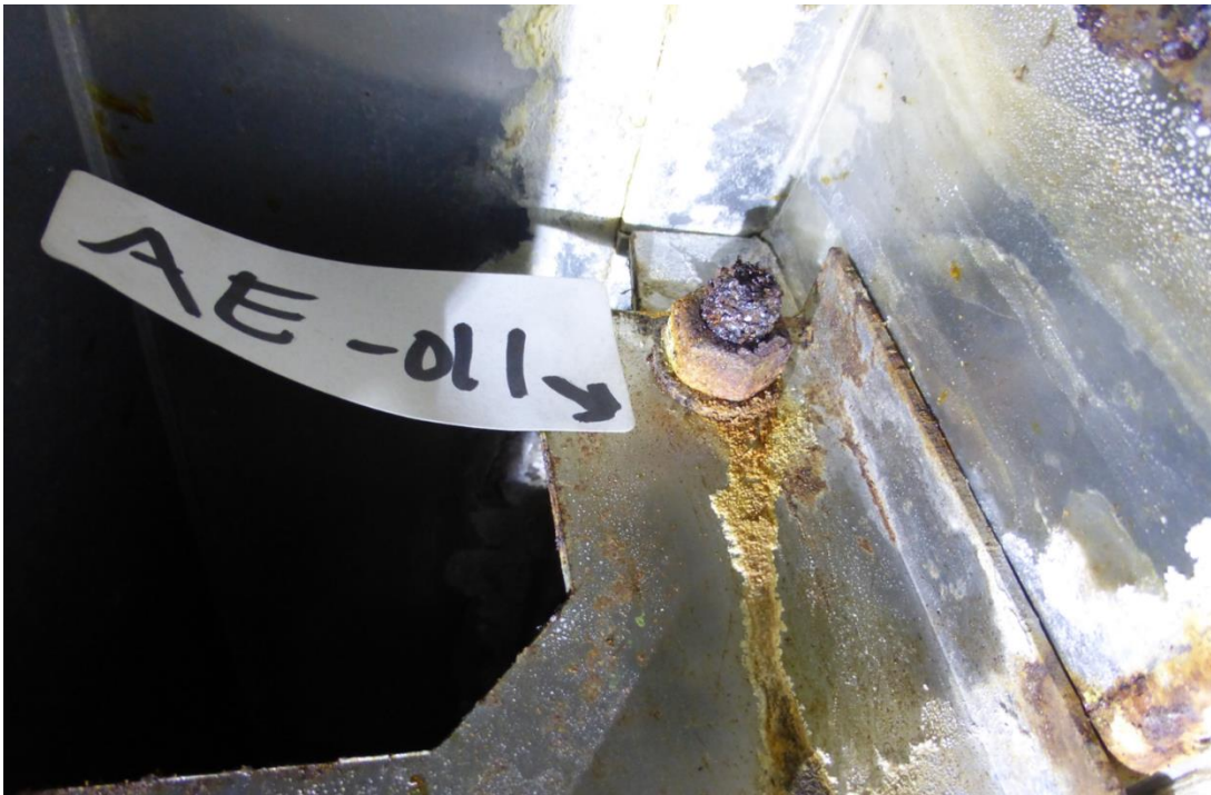
Figuur 13. De bovenste bout tussen de twee verticale zet-randen van de wandplaten van vakken AE-010 en AE-011
