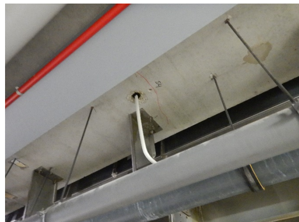
Foto 6.6: Overzichtsfoto onderzoekslocatie S4.
