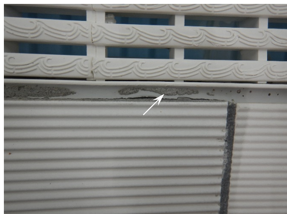
Foto 3.33: Onthechte kitvoeg; deels dichtgesmeerd met voegmortel.
