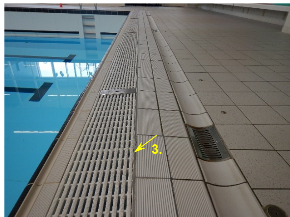
Foto 2: Overzicht overloopgoot zwembad.
