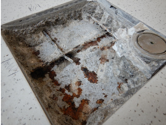
Foto 4.8: Vrijgemaakte bovenzijde 1 e verd. vloer en krimpwapening in dekvloer.
