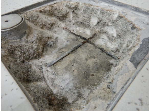
Foto 4.1: Vrijgemaakte bovenzijde 1 e verd. vloer en krimpwapening in dekvloer.
