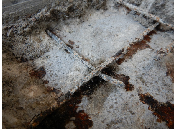
Foto 4.9: Vrijgemaakte bovenzijde 1 e verd. vloer en krimpwapening in dekvloer.
