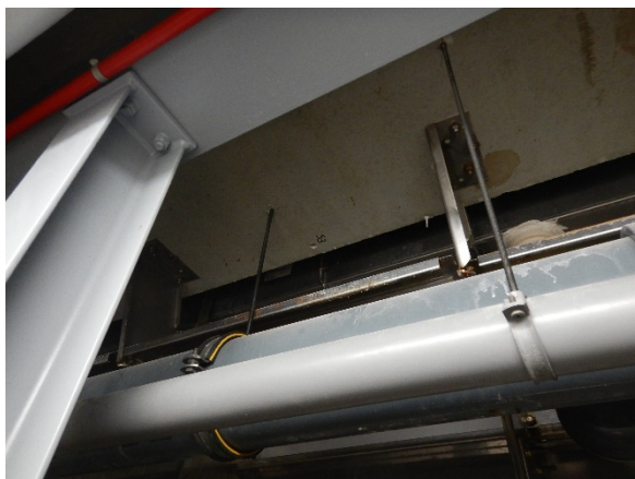
Foto 6.5: Overzichtsfoto onderzoekslocatie S3.
