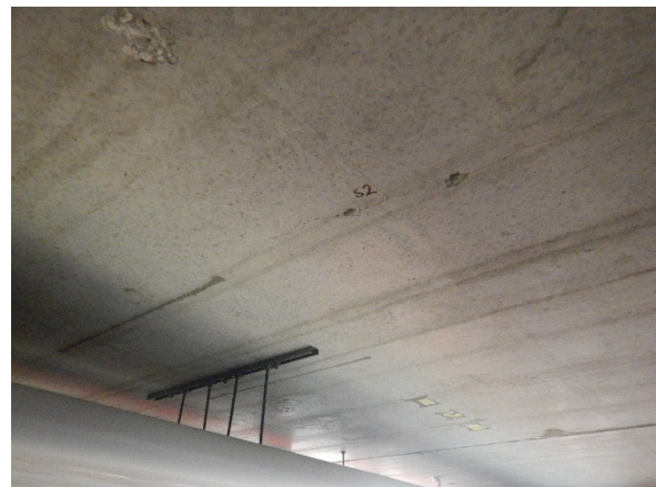
Foto 6.4: Overzichtsfoto onderzoekslocatie S2.
