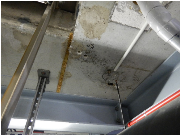
Foto 6.9: Overzichtsfoto onderzoekslocatie S7.
