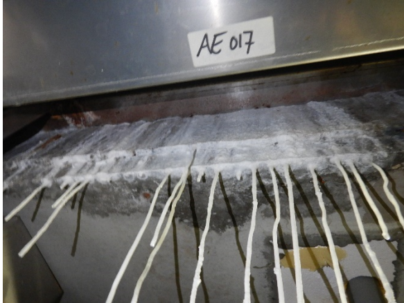
Foto 3.19: Leeksporen onderzijde 1 e verd. vloer; aan binnenzijde vloerrand (loc. 66).
