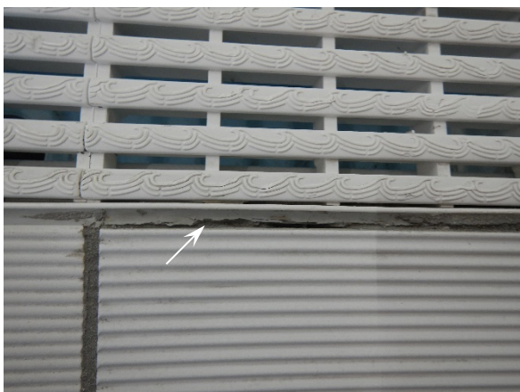
Foto 3.32: Onthechte kitvoeg; deels dichtgesmeerd met voegmortel.
