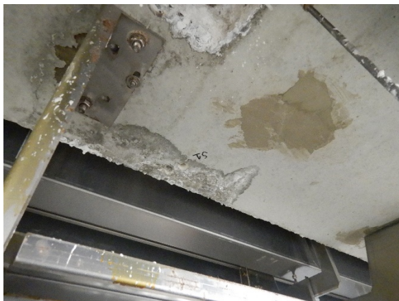
Foto 6.3: Overzichtsfoto onderzoekslocatie S1.
