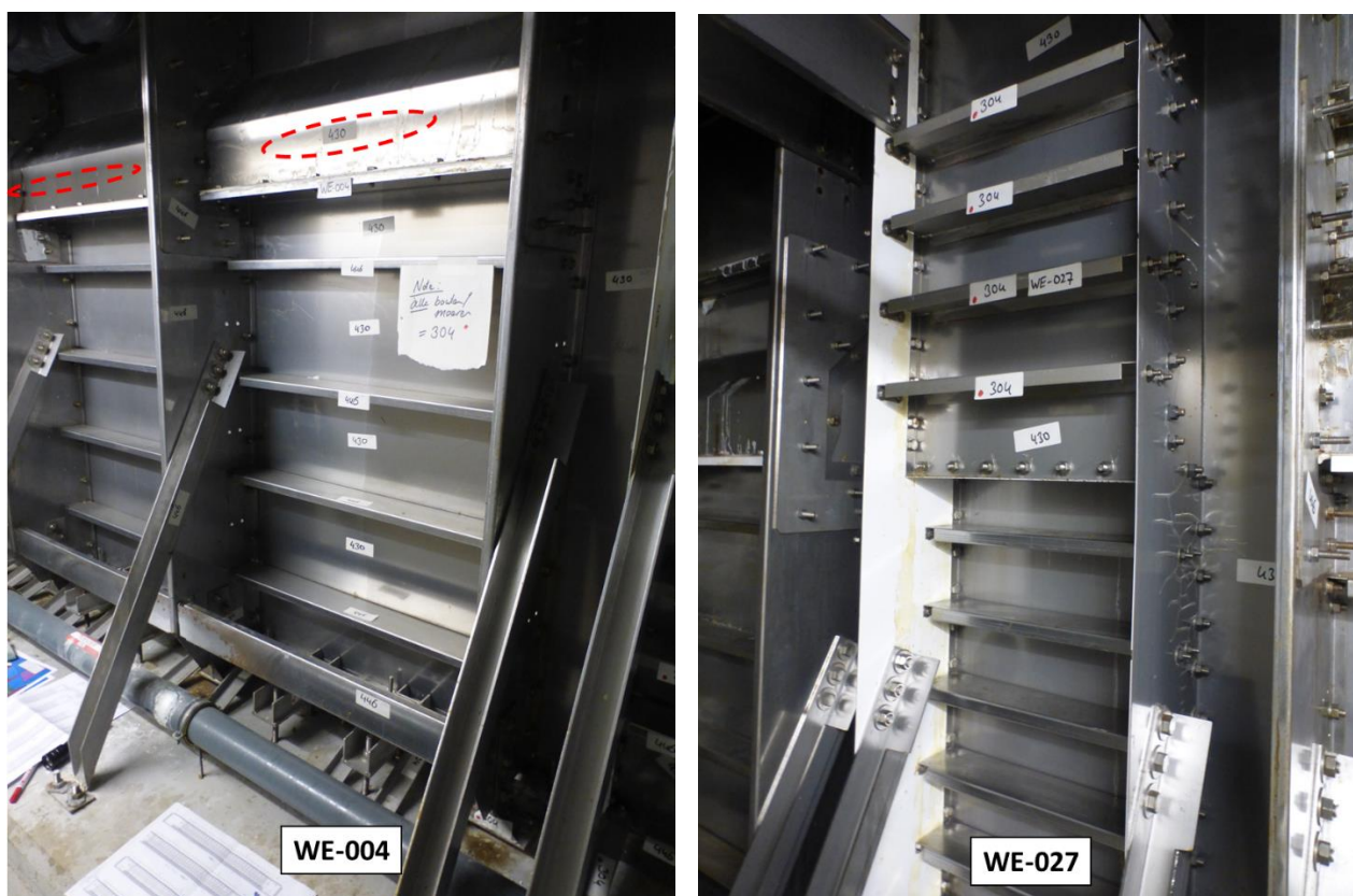
Figuur 1. De opbouw van de vakken was in grote lijnen steeds hetzelfde. De foto links (vak WE-004) toont een wandplaat aan de waterzijde met horizontale en verticale elementen/ribben om de constructie sterkte en stijfheid te geven. De verticale ribben worden extra gesteund door schuine schoren. De rood gestippelde ellipsen duiden de loopgoot aan (enkel aanwezig aan de lange zijden). De foto rechts toont een afwijkend vak (WE-027) met een apart 'kamertje' en aanvullende verticale en horizontale ribben. Vakken WE-004 en WE-027 waren relatief schoon met op het oog weinig aantasting.)
