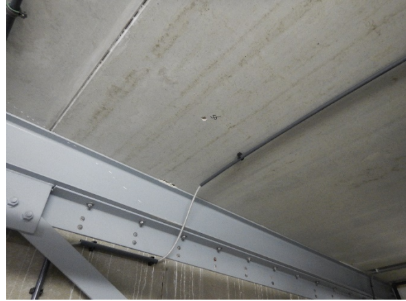
Foto 6.8: Overzichtsfoto onderzoekslocatie S6.
