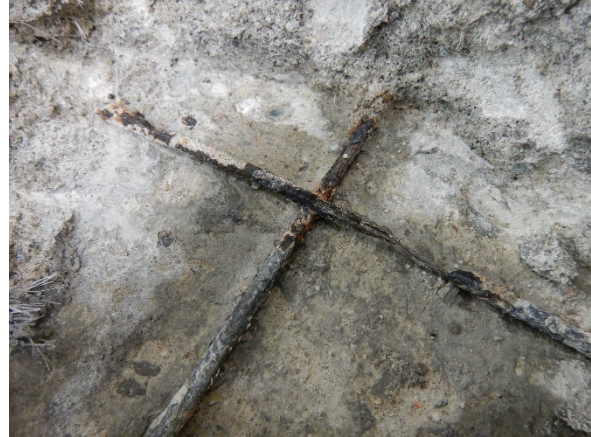
Foto 4.2: Vrijgemaakte bovenzijde 1 e verd. vloer en krimpwapening in dekvloer.
