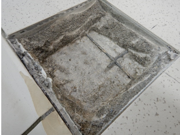
Foto 4.5: Vrijgemaakte bovenzijde 1 e verd. vloer en krimpwapening in dekvloer.
