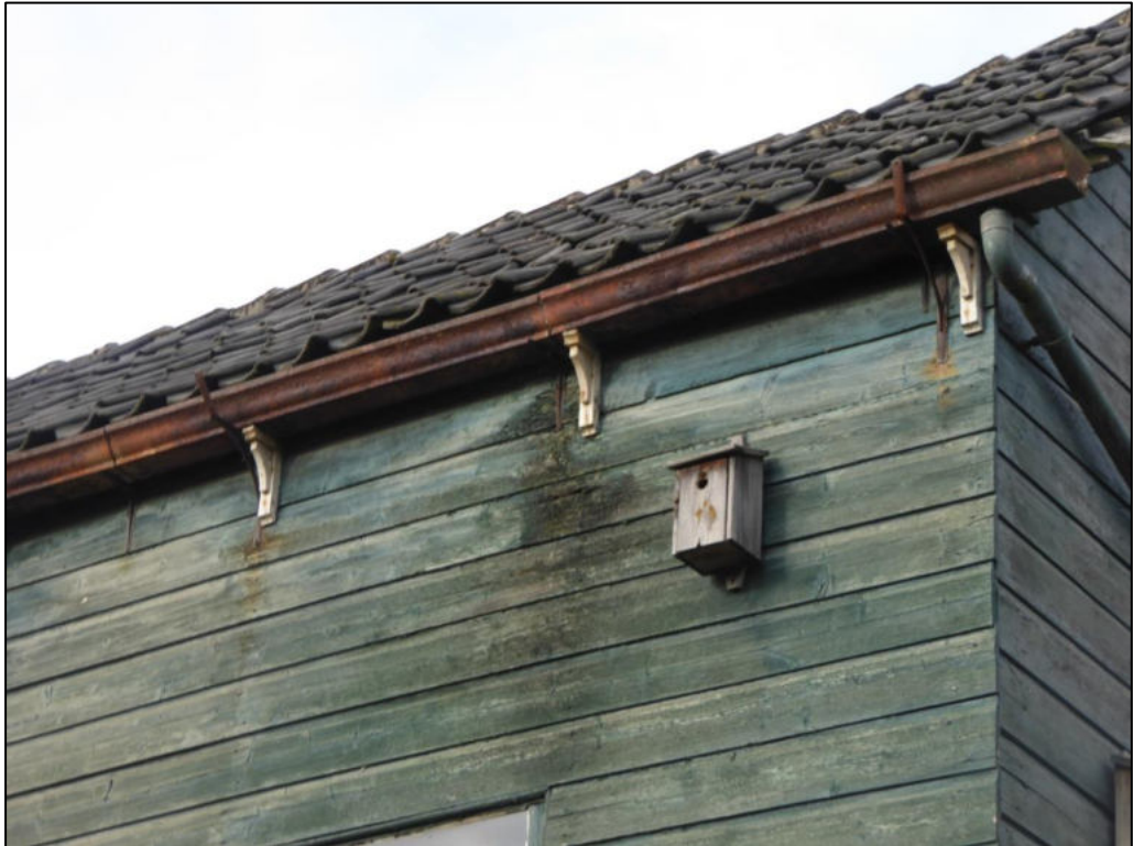
Onder de daken kunnen huismussen en gierzwaluwen broeden
