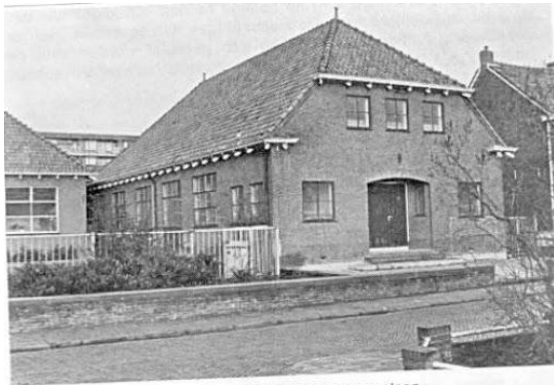
Gymnastieklokaal Lelsstraat: op de nominatie voor sloop.
